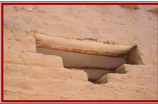
Vano de forma escalonada simétrica
