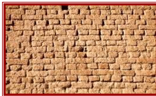
Muro de ladrillo crudo de Cabeza Foto: e-struc
