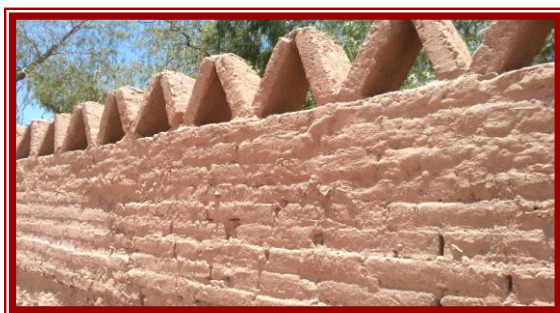
Muro de adobe de 40 x40, con detalle moche Foto: e-struc
