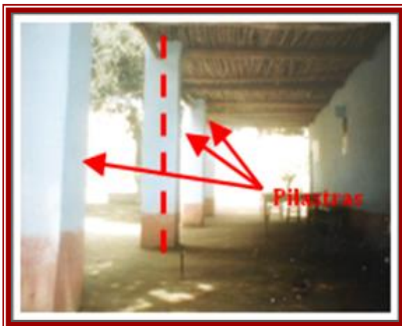
Vista de Pilastras en Ramada / Fuente Propia
