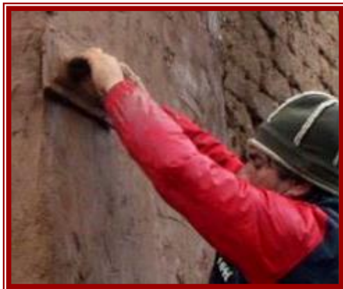
Proceso de enlucido de muro de adobe Foto: Artotems en flickr
