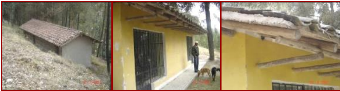
Vistas exteriores de las cabañas de hospedaje, cada cabaña consta de dos habitaciones con baño. (D)
