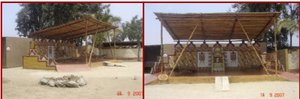
En esta techumbre se aprecia el uso de bambú, madera eucalipto con estera y caña carrizo. / Fuente Propia
