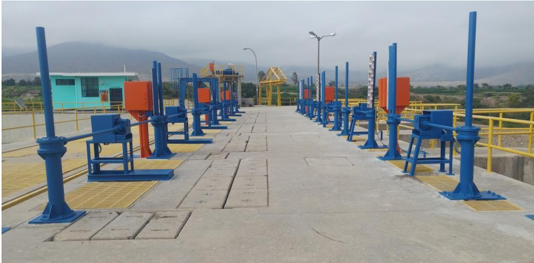
Figura 104. Plataforma de operaciones.
