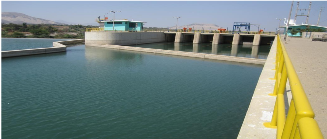
Figura 102. Esclusa de captación.
