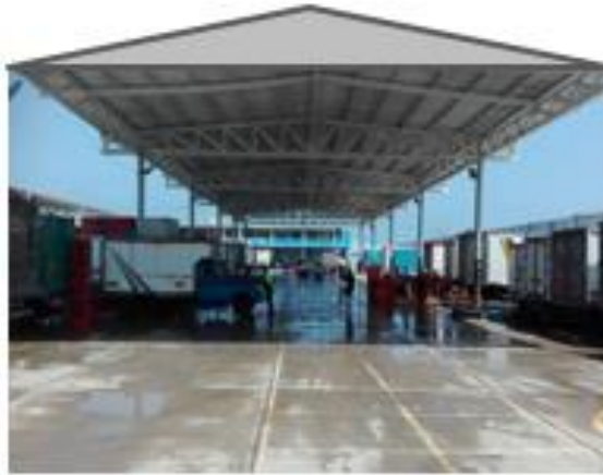
Nave a dos Aguas - Envoltente (Área de Ventas)
