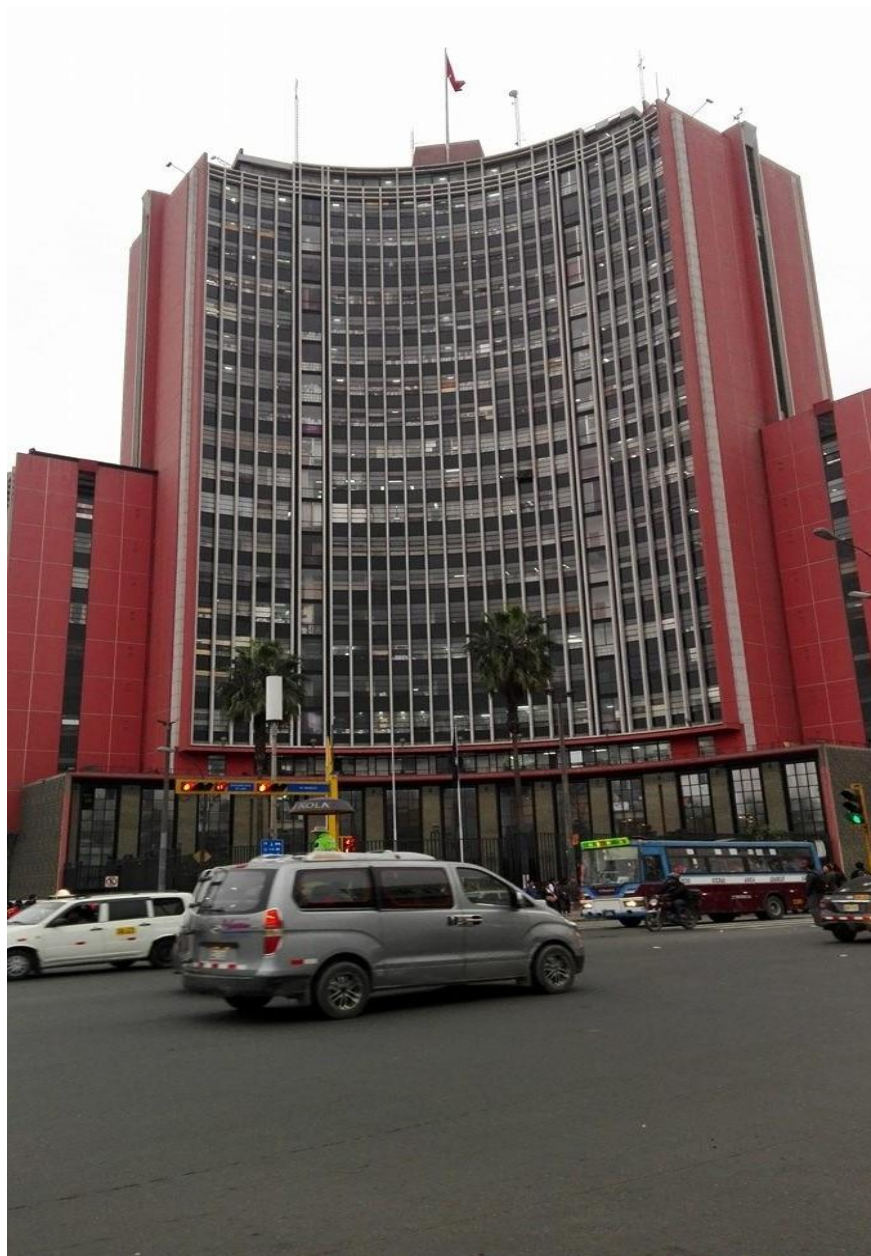
Figura 1 Fotografía tomada al Local de Corte Superior de Lima. Perú. Elaboración propia. (2018)
