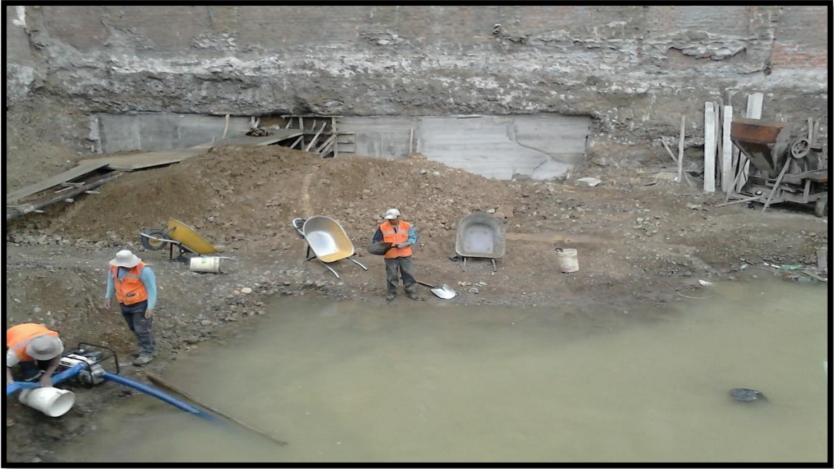
Figura 3. Napa freática muy alta
