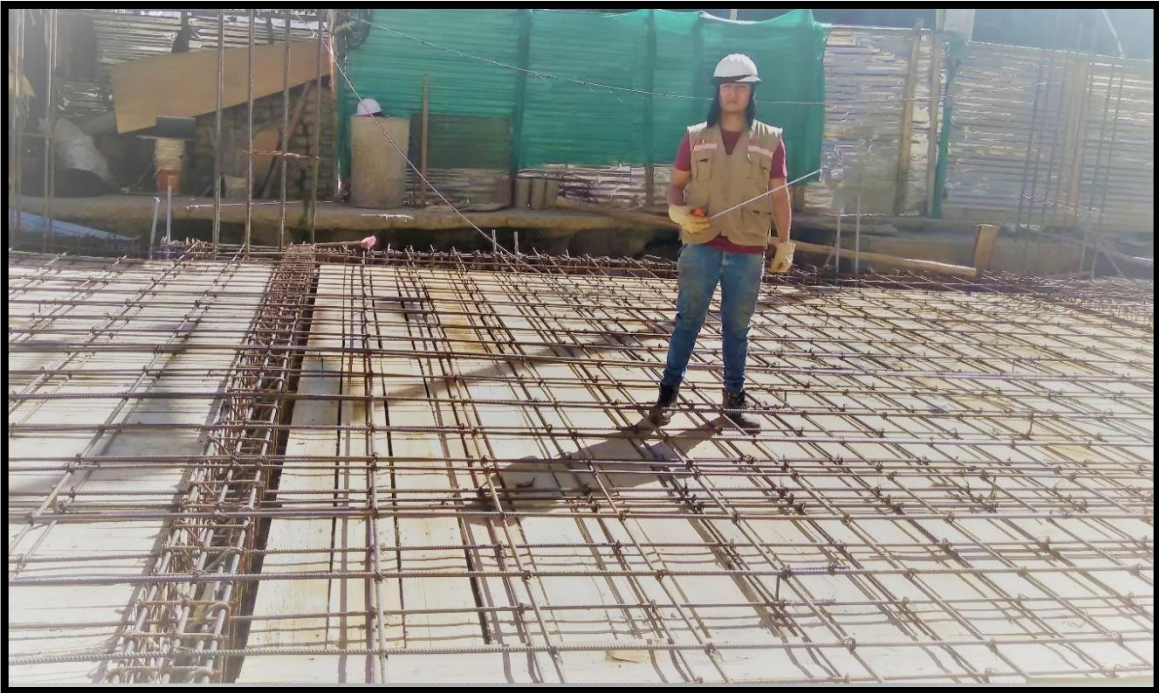
Figura 22. Acero del techo del sótano
