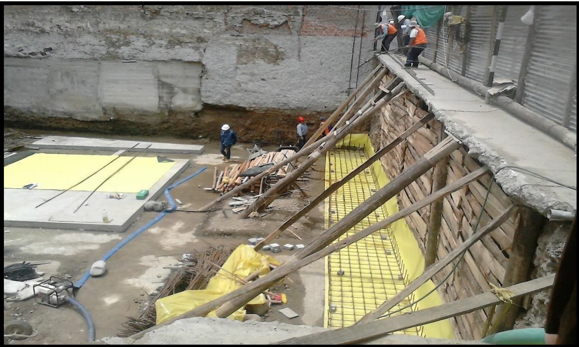
Solado 12. Colocación de la geomenbrana y la parrilla para la zapata corrida
