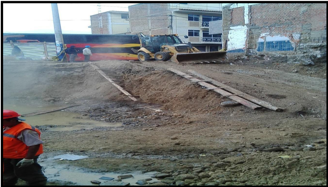
Figura 2. La excavación a -4.5m del NR (vereda) usando una retroexcavadora y volquete
