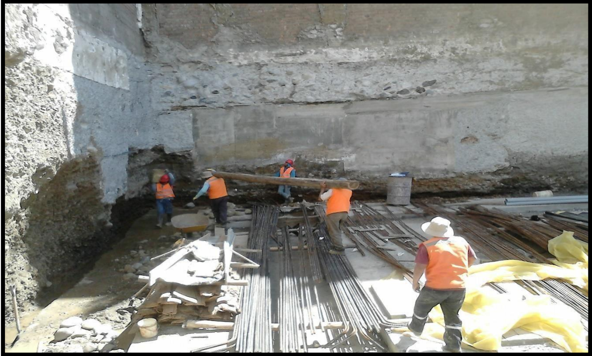
Figura 13. Excavación en el perímetro del terreno para canalizar la napa freática alta
