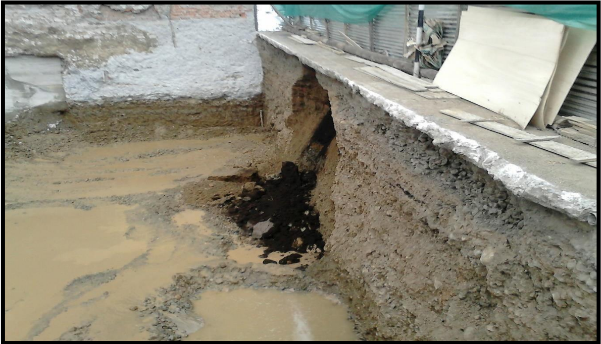
Figura 9. Se vino abajo el terreno lateral por la napa freática alta y el movimiento vehicular
