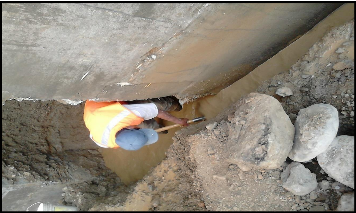
Figura 4. Trabajo de excavación para calzada con napa freática alta
