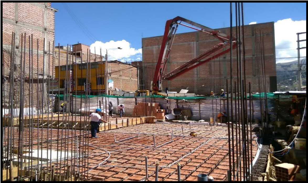
Figura 23. Preparando para el vaciado del techo del sótano
