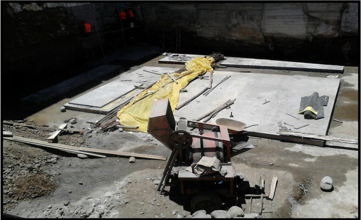
Figura 11. Solado para la zapata corrida y para la losa de cimentación
