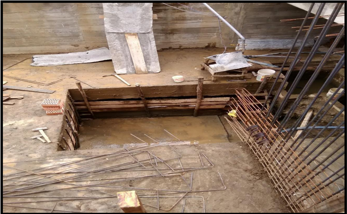
Figura 16. Solado del ascensor
