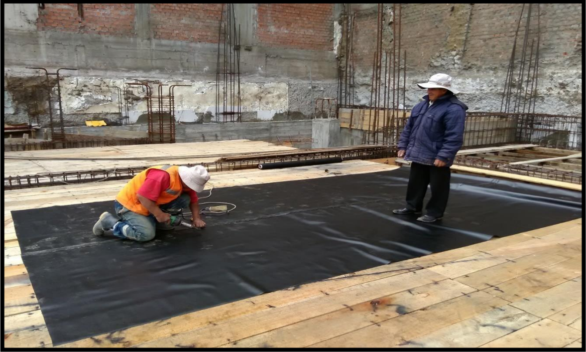
Figura 15. Preparando la geomembrana para el ascensor
