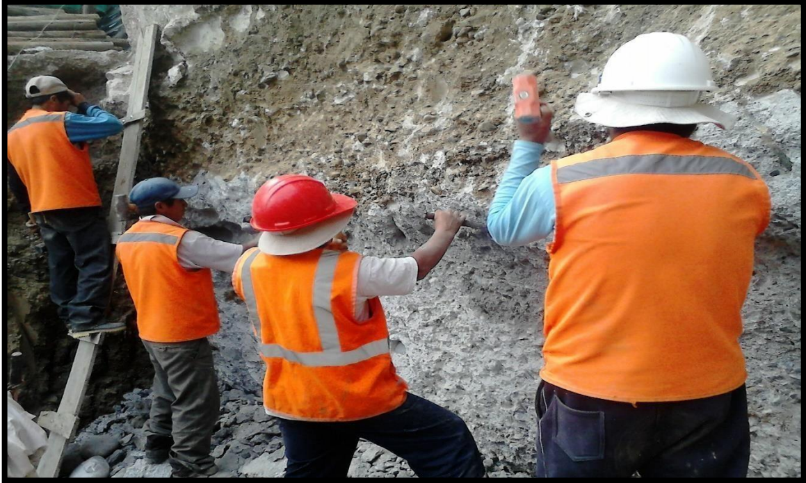
Figura 7. Picado en la dirección Y de la edificación colindante
