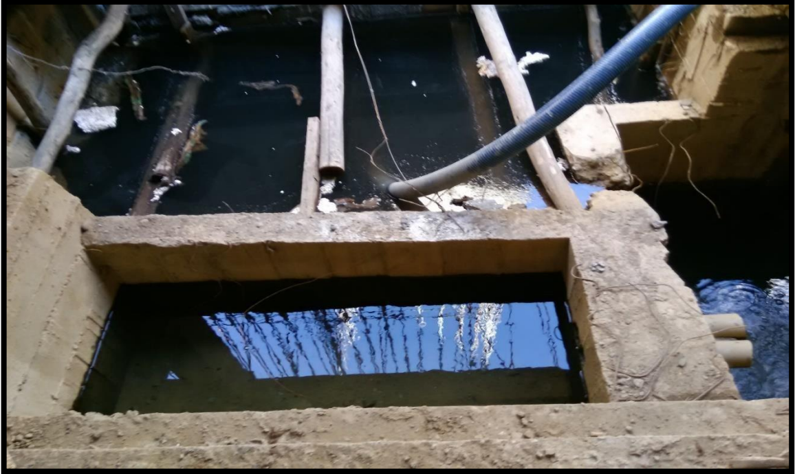
Figura 19. El desarenador
