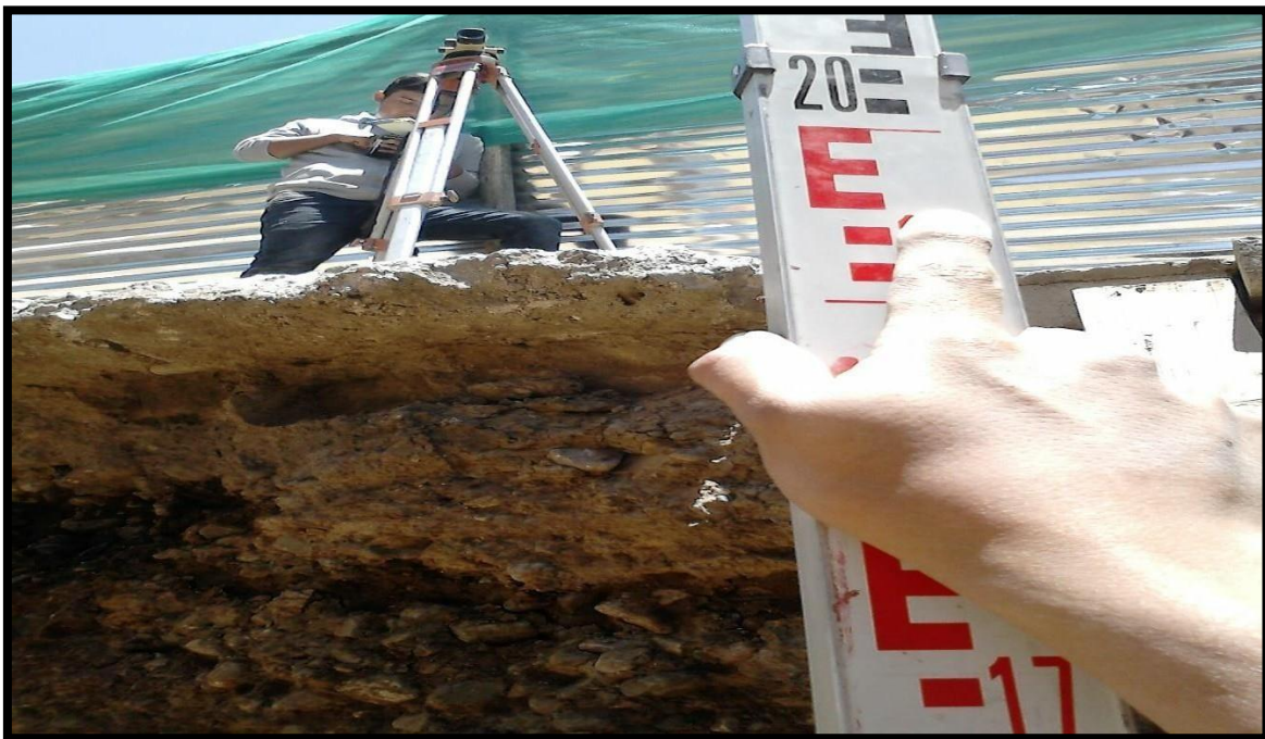
Figura 8. Nivelación del terreno
