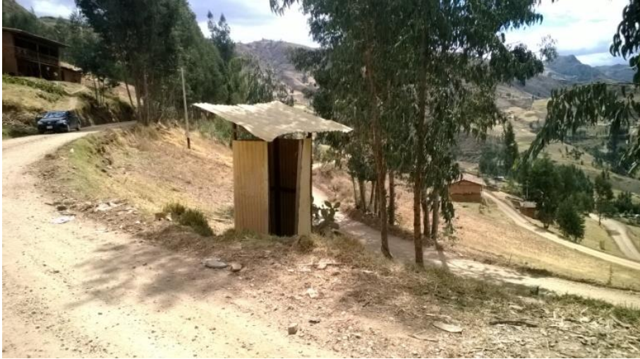
Figura 14. Vista de letrinas de hoyo seco caserío Totorapampa
