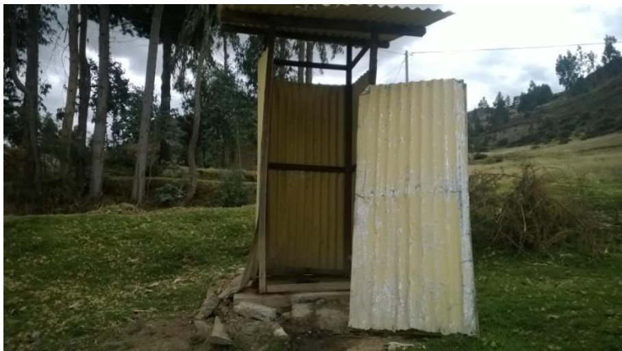
Figura 13. Vista letrinas de hoyo seco caserío Tambopampamarca, Fuente: Elaboración propia
