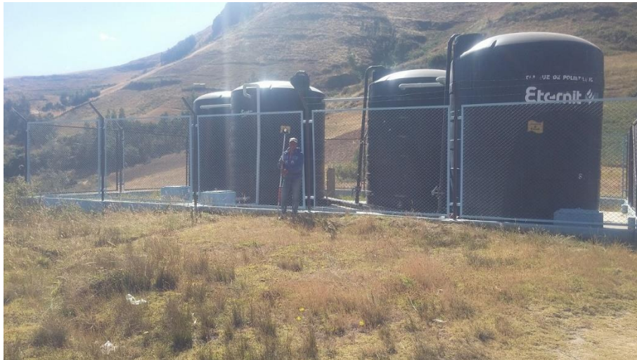
Figura 9. Vista de reservorios existentes, de donde se hará la conexión de las líneas conducción
