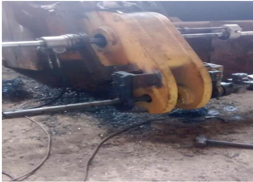
Figura: 11 Maquinado de Alojamiento
