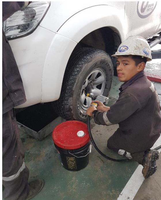
Figura 11. Personal mecánico realizando desmontaje de neumático.
