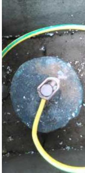
Fig. 2.4 Cemento Conductivo adherido a una barra
