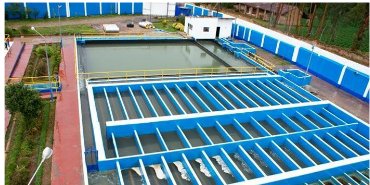
Planta de tratamiento SEDAM - Huancayo
