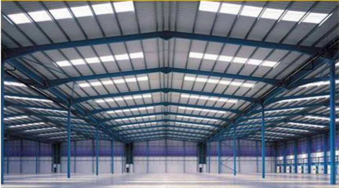
Figura 8. Nave industrial de estructura de alma llena
