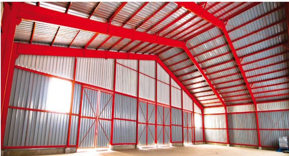
Figura 9. Nave industrial con sistema metálico Tubest.
