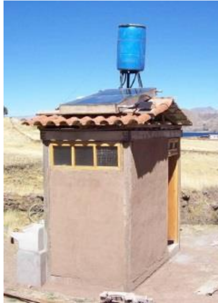
Figura 137. Baño ecológico con biodigestor.
