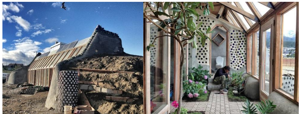
Figura 129. Vista exterior e interior de la vivienda.
