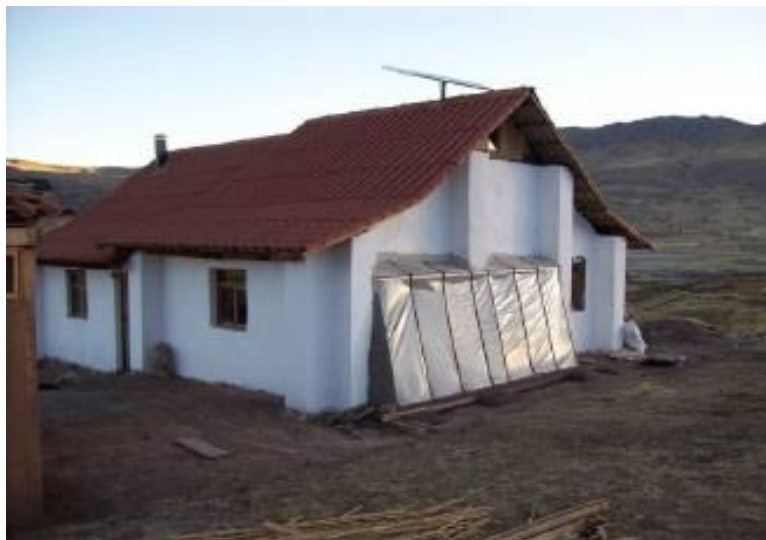
Figura 134. Muro caliente para calentar habitaciones.
