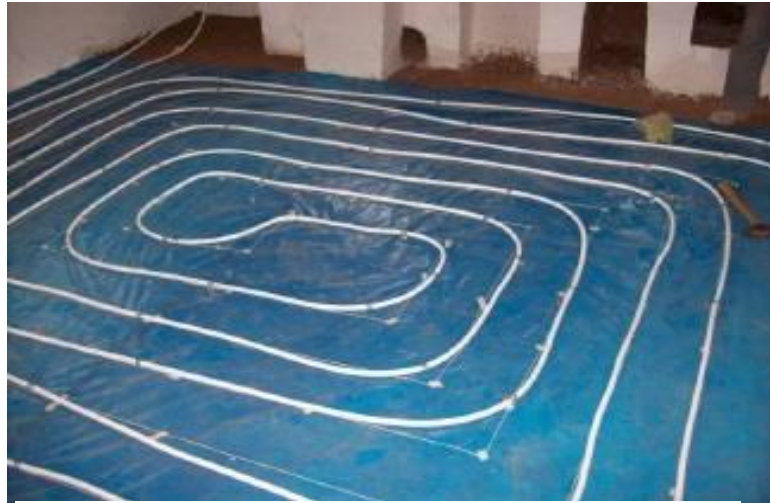
Figura 133. Piso radiante para calentar áreas sociales.
