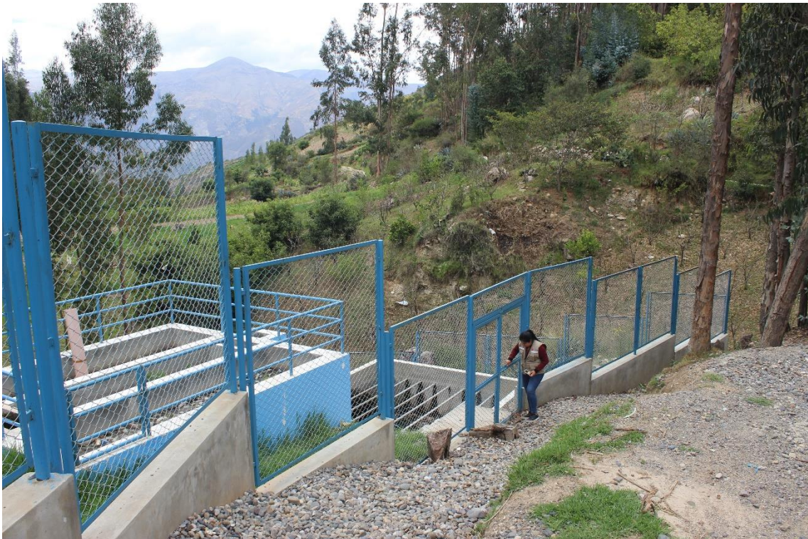
Figura 21 Acceso a la Planta de tratamiento de aguas residuales
