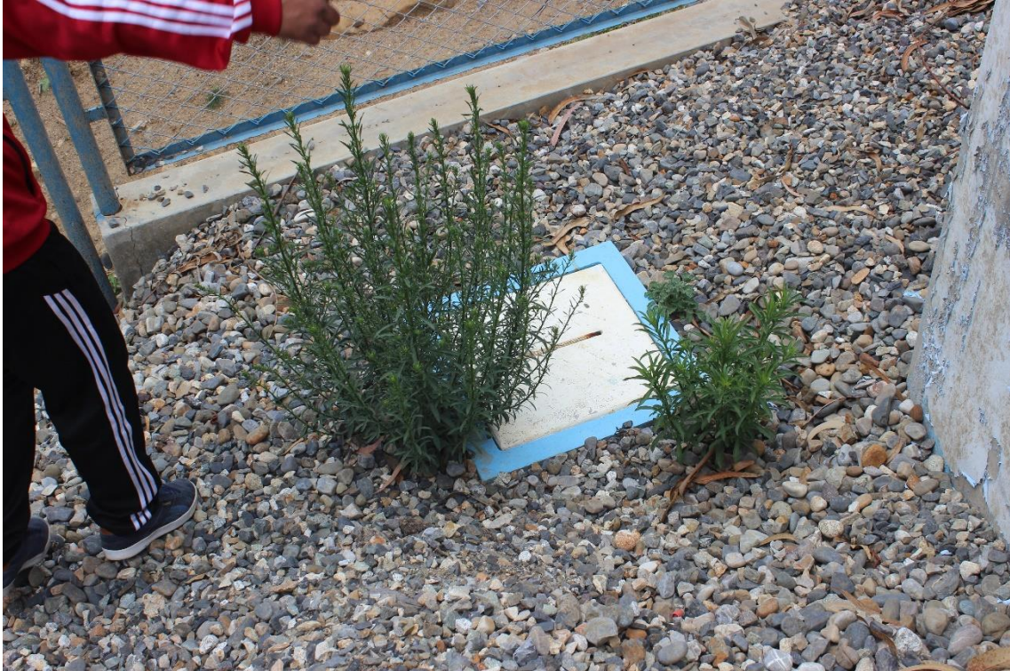
Figura 59 Patologías en el Contacto de Cloro de la Planta de tratamiento de aguas residuales
