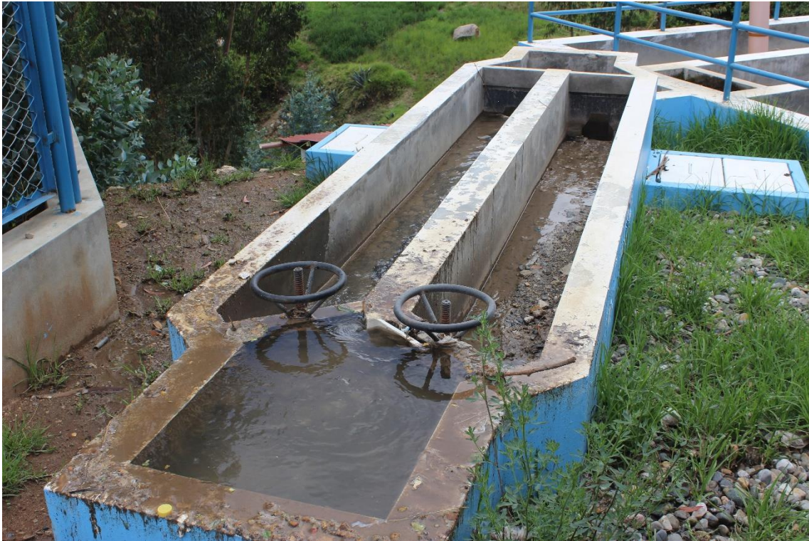
Figura 28 Vista superior trasera de la cámara de rejas de la Planta de tratamiento de aguas residuales
