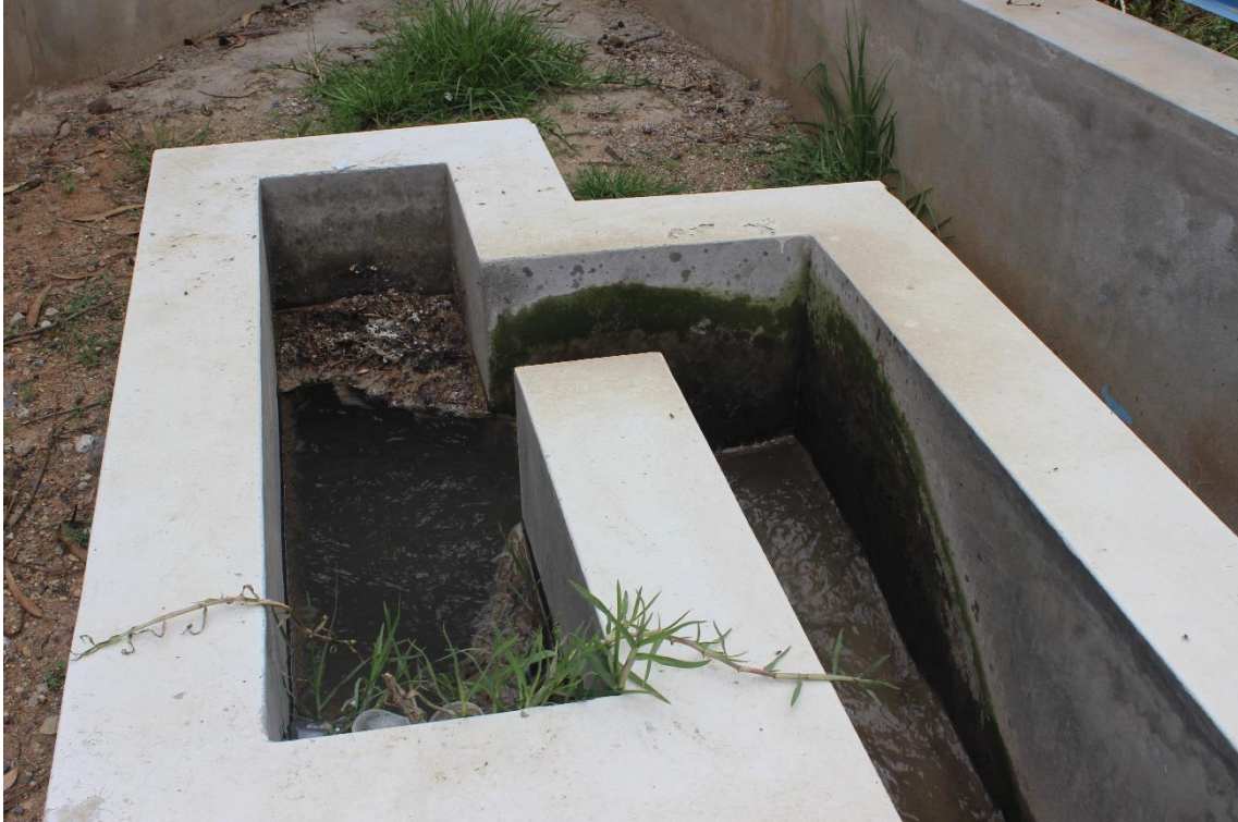
Figura 27 Vista superior frontal de la cámara de rejillas de la Planta de tratamiento de aguas residuales
