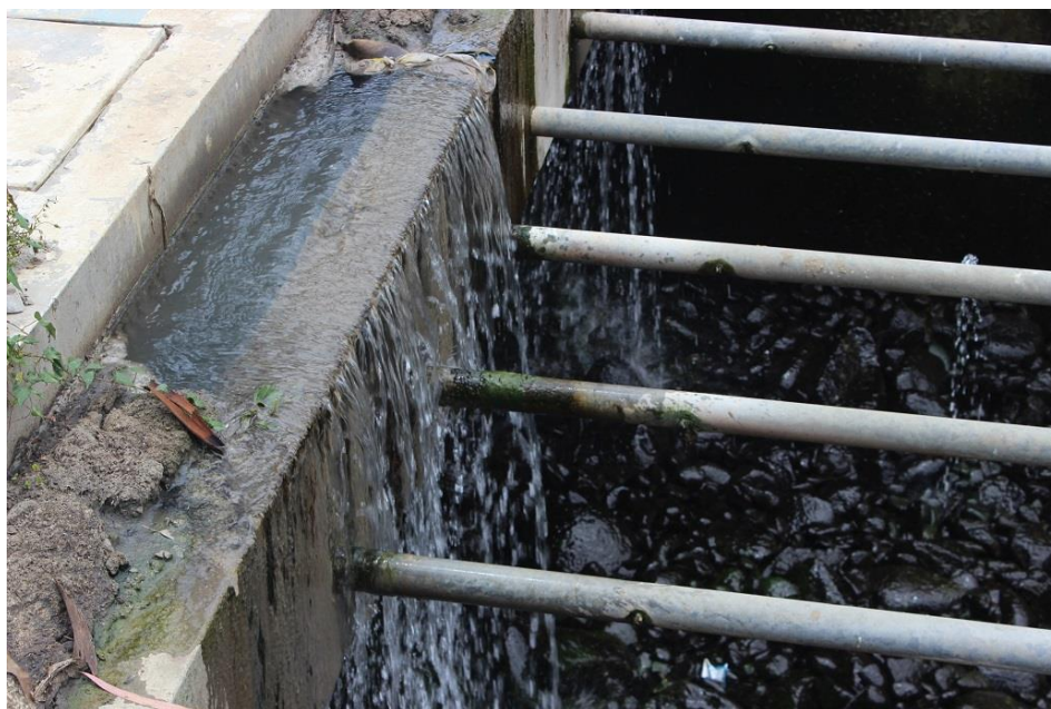
Figura 4: Filtro biológico de la PTAR Amashca
