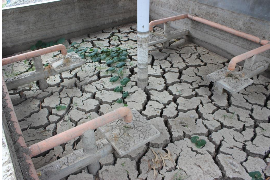
Figura 5: Lecho de secado de la PTAR Amashca
