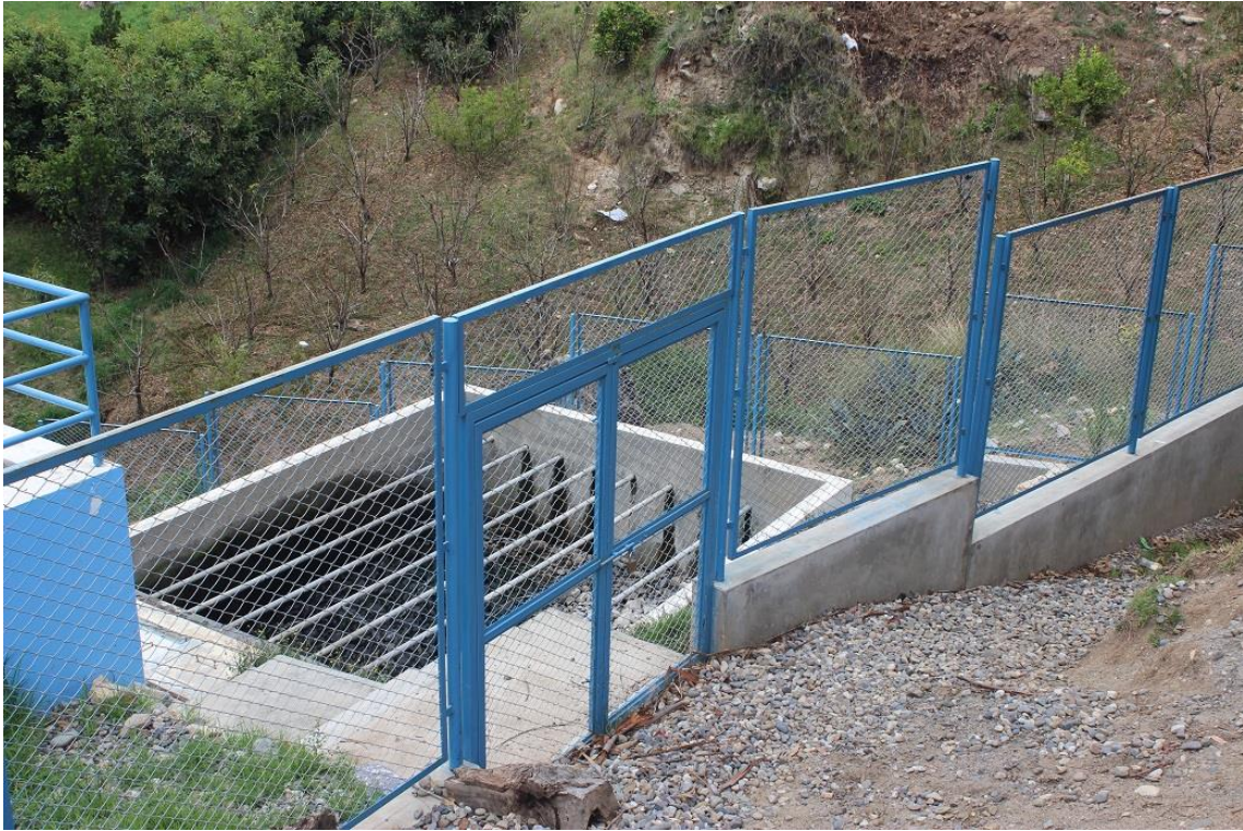
Figura 18 Vista externa de la Planta de tratamiento de aguas residuales
