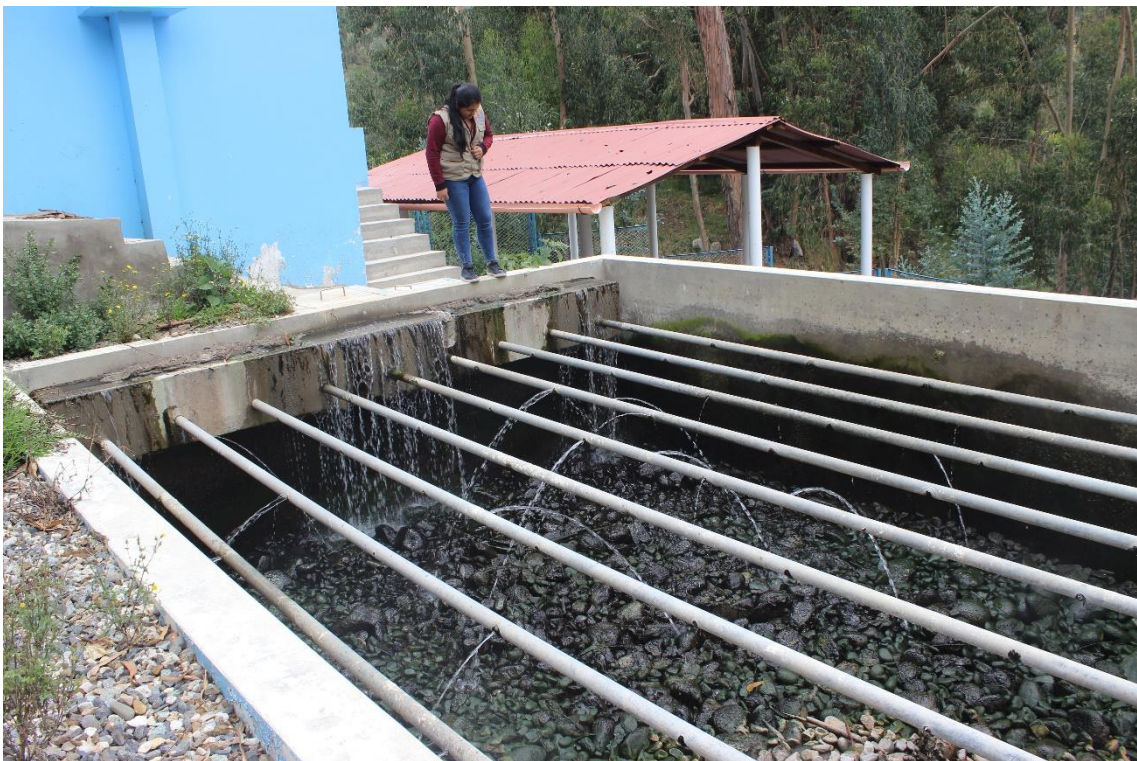
Figura 39 Vista delantera lateral del filtro biológico de la Planta de tratamiento de aguas residuales
