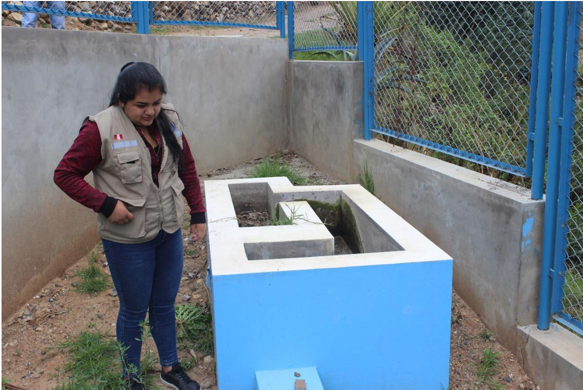
Figura 26 Vista frontal de la cámara de rejillas de la Planta de tratamiento de aguas residuales
