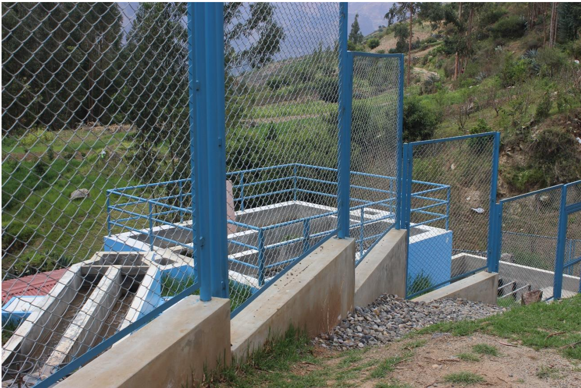
Figura 19 Vista externa de la Planta de tratamiento de aguas residuales
