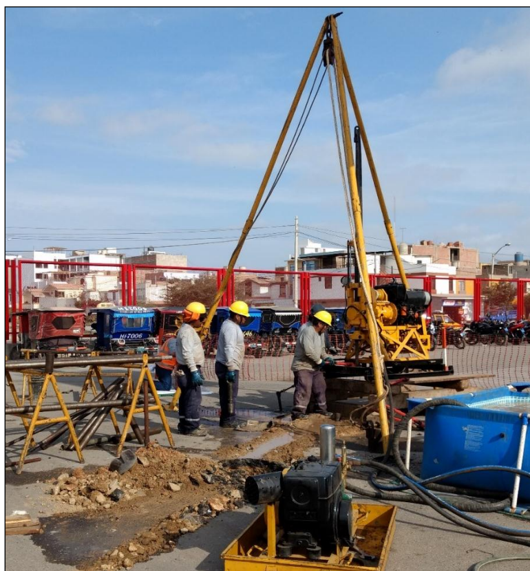
FIGURA N° 3: Perforación Rotativa (Fuente: Propia, 2017)
