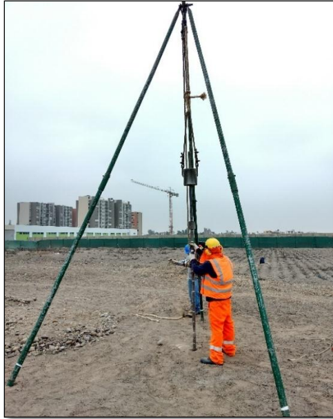
FIGURA N°1: Ensayo de Penetración Estandar. (Fuente: propia, 2017)
