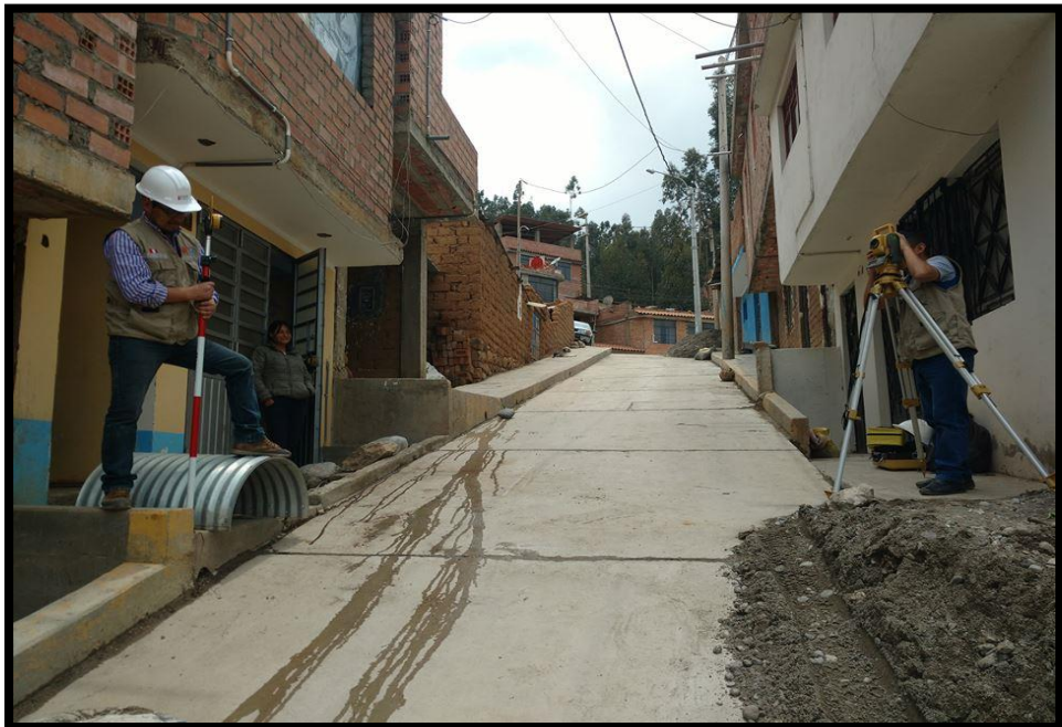
TOMANDO LOS PUNTOS PARA EL LEVANTAMIENTO TOPOGRÁFICO
