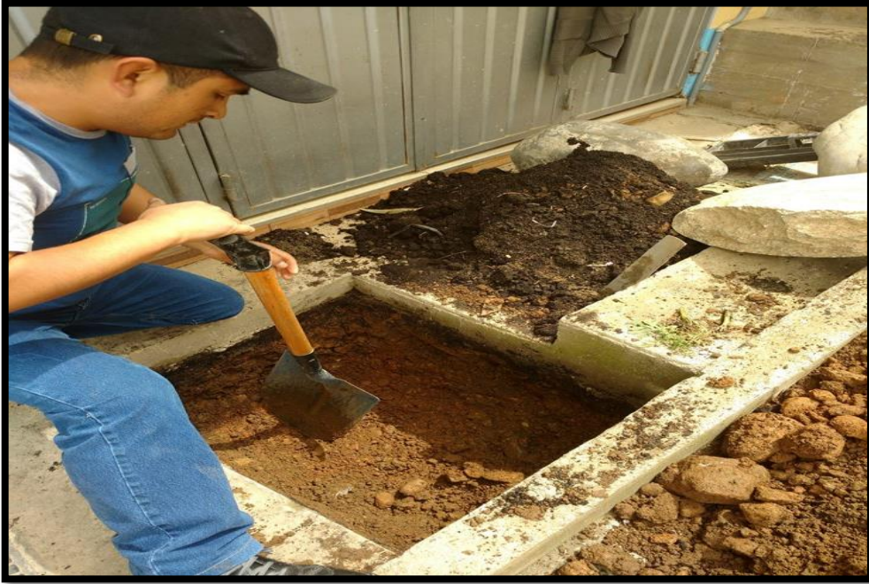
EMPEZANDO LA EXCAVACIÓN DE LA CALICATA
