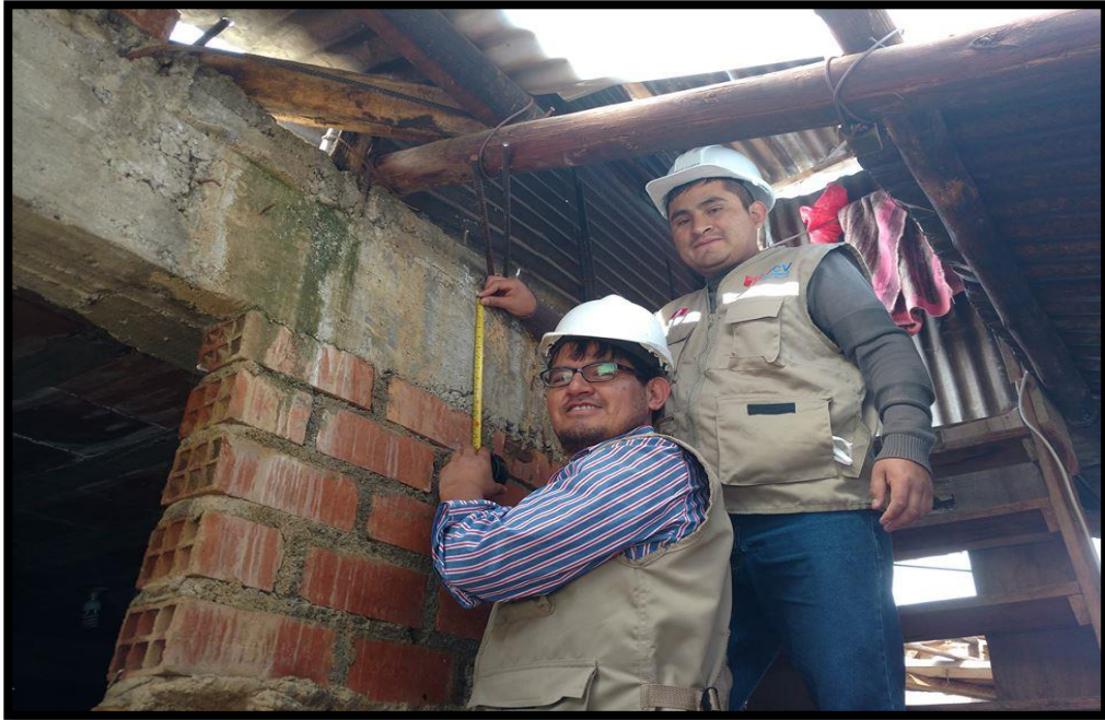
TOMANDO LA MEDIDA DEL PERALTE DE LA VIGA Y LOSA
