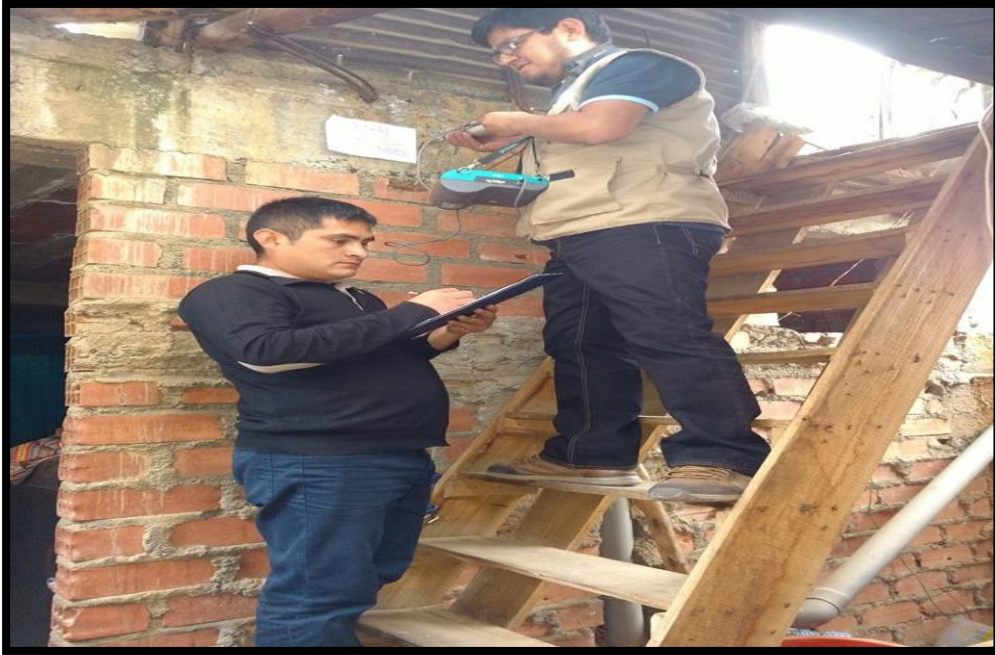
PRUEBA DE ESCLEROMETRÍA A LA VIGA DEL SEGUNDO NIVEL
