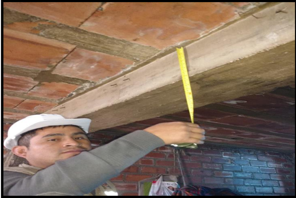
TOMANDO LA MEDIDA DEL PERALTE DE LA VIGA DEL SEGUNDO NIVEL
