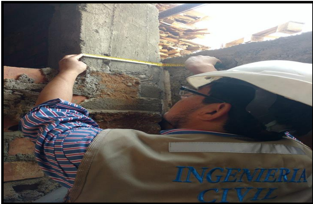
TOMANDO LA MEDIDA DEL PERALTE DE LA COLUMNA DEL SEGUNDO NIVEL
