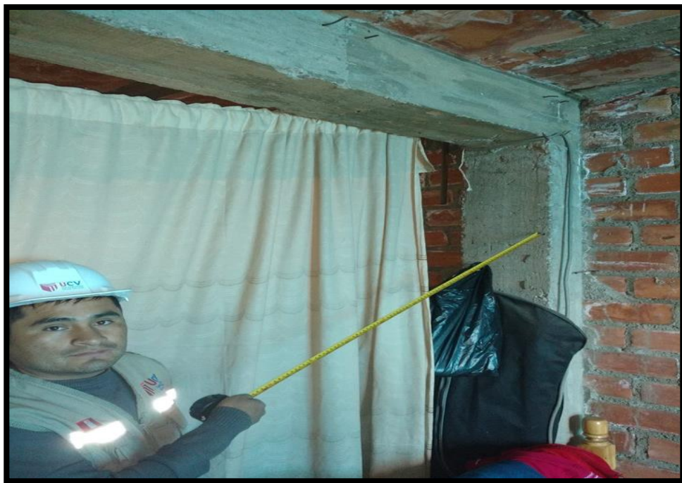
UNIÓN DE COLUMNA Y VIGA (PÓRTICO)
