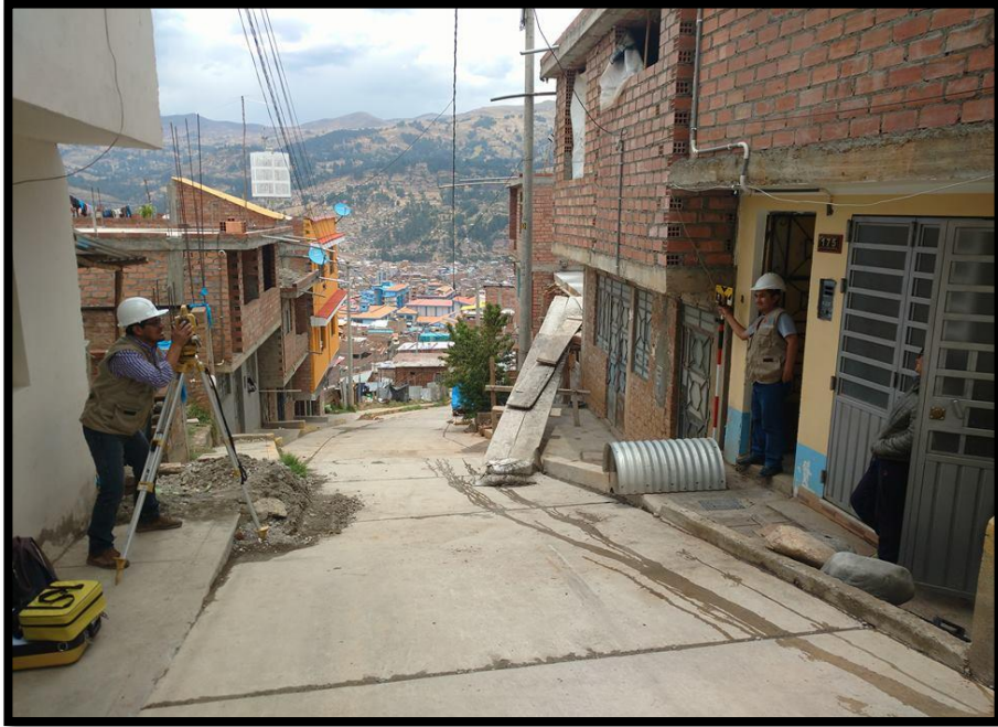
TOMANDO LOS PUNTOS TOPOGRÁFICO
