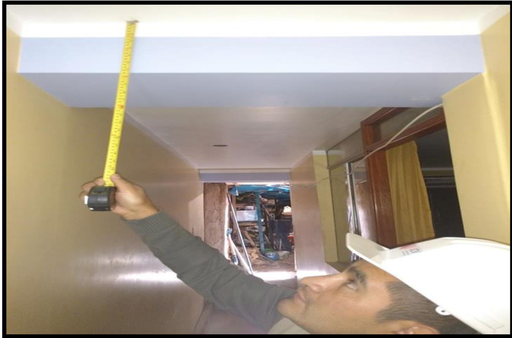
TOMANDO LA MEDIAD DEL PERALTE DE LA VIGA
