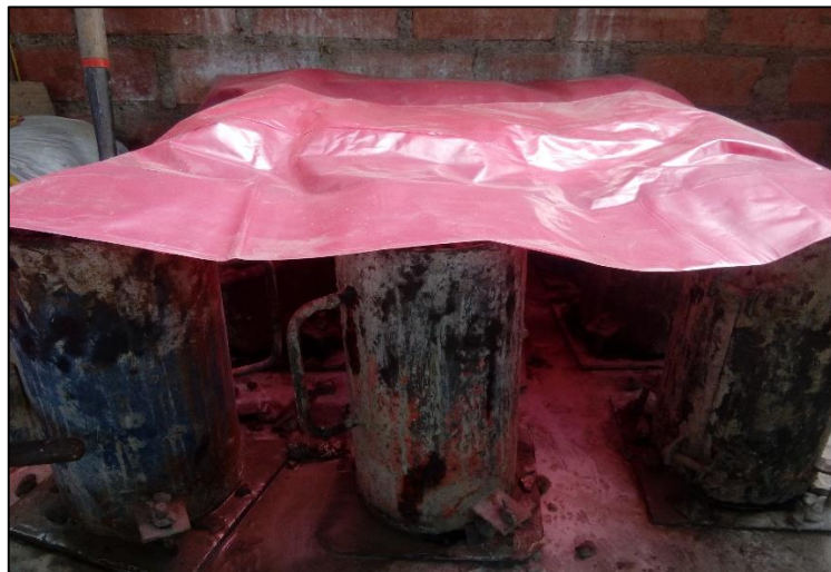
Figura 25: Curado Inicial de Concreto Permeable
