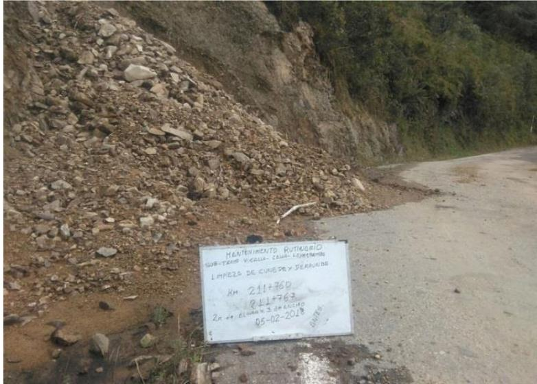
Figura 3-5: Acumulación de material debido a derrumbe. Fuente: Propia
