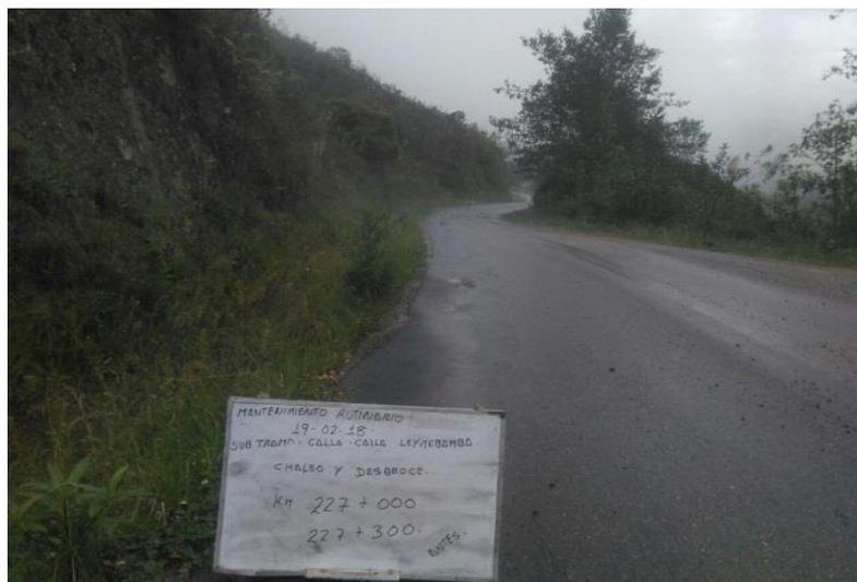
Figura 3-4: Cunetas colmatadas por presencia de vegetación. Fuente: Propia
