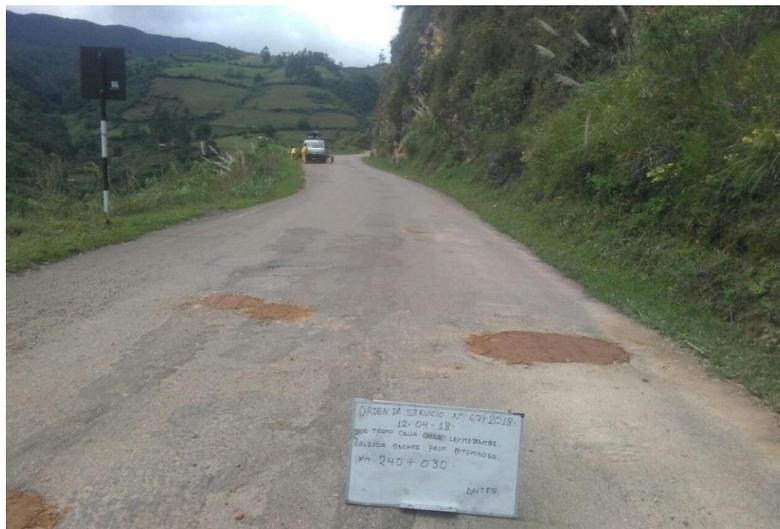
Figura 3-3: Presencia de baches parcialmente rellenos. Fuente: Propia
