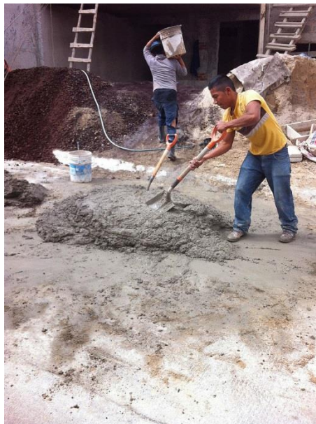
Figura 1. Preparación del concreto en las autoconstrucciones. Fuente: Unimedios. Universidad Nacional de Colombia.
