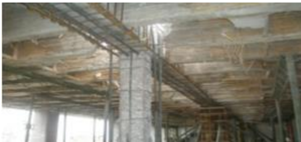
Figura 1.1 Reforzamiento con encamisado de concreto
