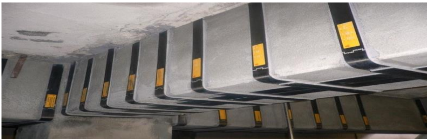
Figura 1.3 Reforzamiento con fibra de carbono
