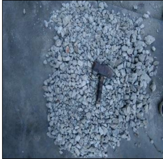
Figura 30: Material demolido de concreto
