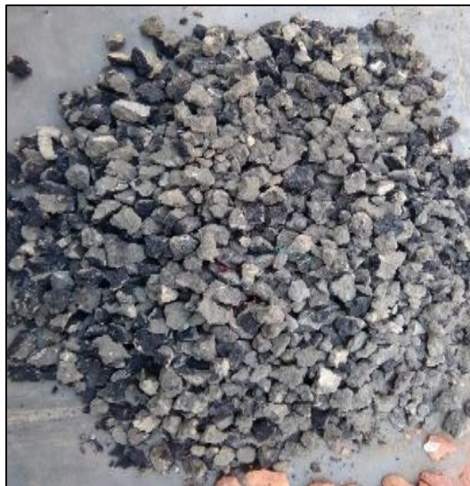
Figura 31: Material demolido de pavimento flexible
