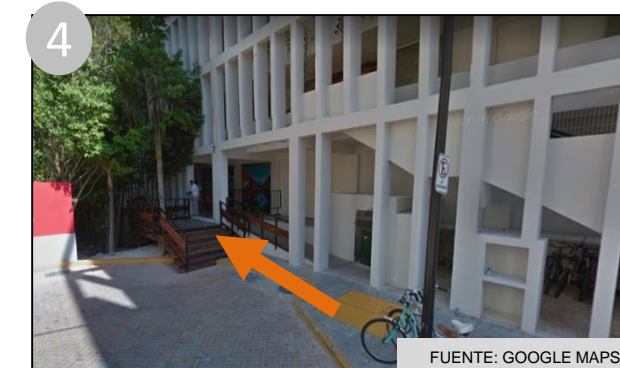
4 INGRESO DE SERVICIO
