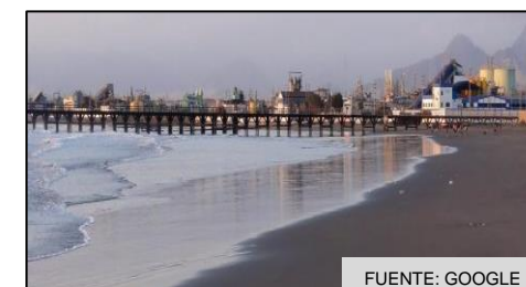
Muelle de Puerto Malabrigo
