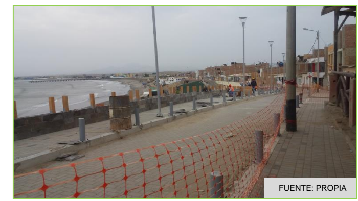
En la imagen se observa la construcción del malecón, en donde se puede observar mobiliarios urbanos, como pérgolas, favores y bancas.
