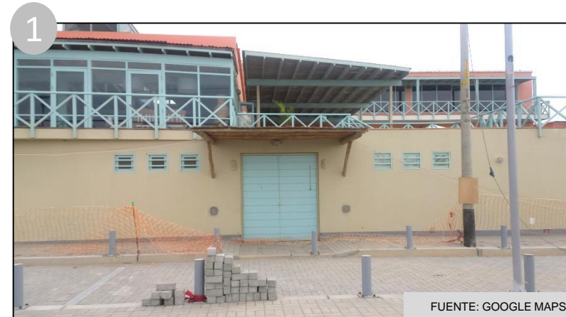
INGRESO SECUNDARIO POR LA CALLE ARICA
