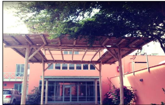
VISTA EXTERIOR DE LOBBY
