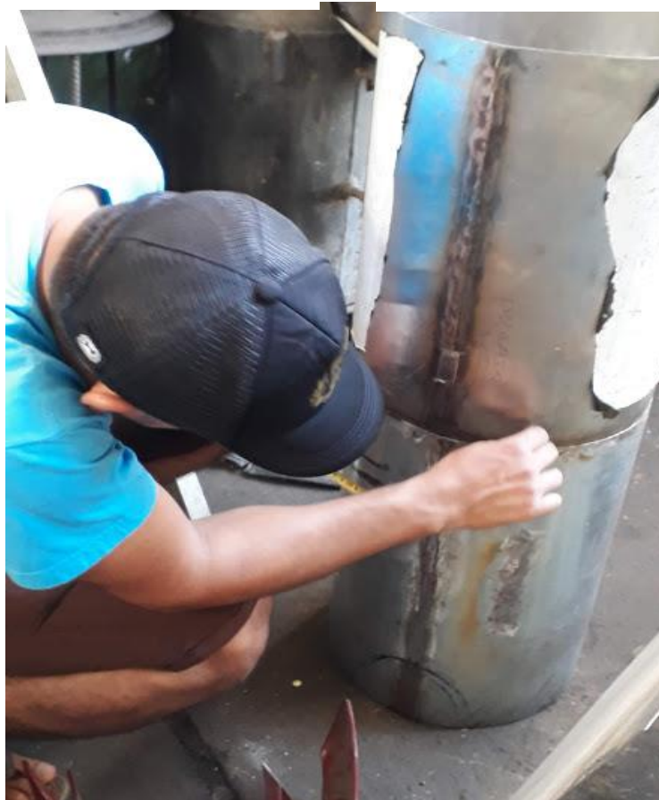
Imagen 6. Montaje de la base del cilindro.
