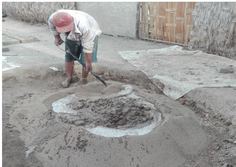
Fotografía 9. Mezcla del suelo con agua
