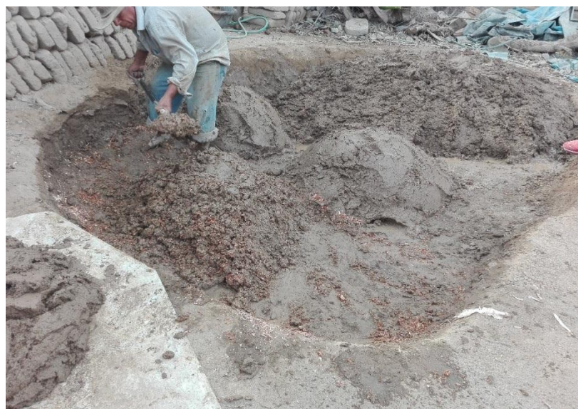
Fotografía 12. Mezcla de viruta con el barro
