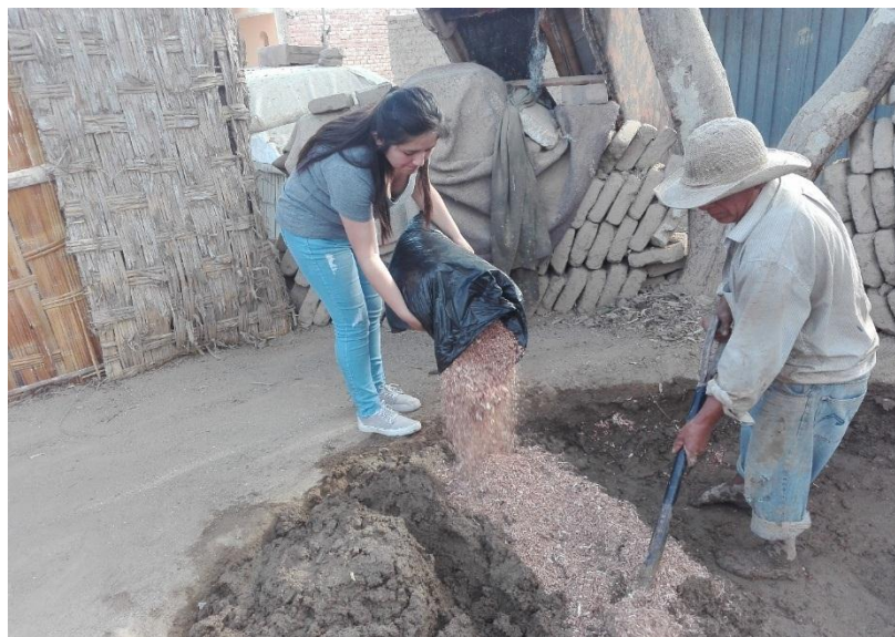
Fotografía 11. Adición de la viruta al barro
