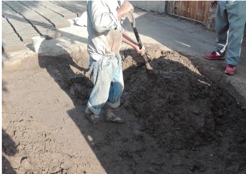
Fotografía 10. Resultado de la mezcla del suelo con agua
