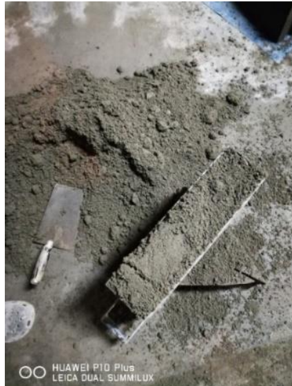
Figura 33: proceso de moldeado de bloquetas para uso estructural
