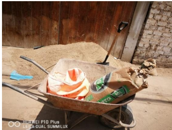
Figura 23: Procedimiento colocación de materiales en bolsas
