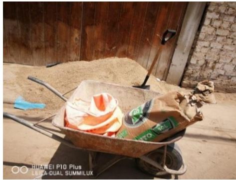
Figura 16: Procedimiento colocación de materiales en bolsas
