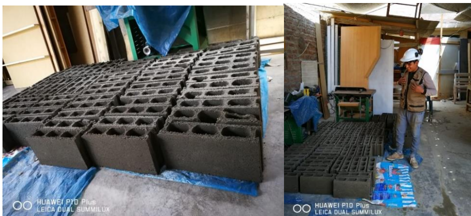
Figura 27: Proceso de elaboración de bloquetas para uso no estructural
