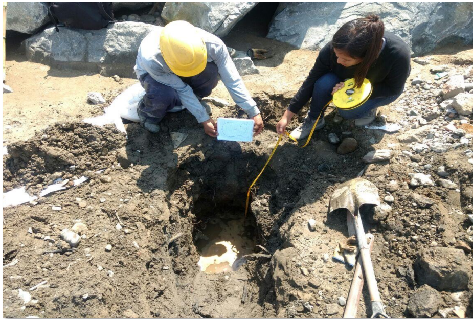
Tesista y personal en la medición de la profundidad alcanzada por la calicata N°2.
