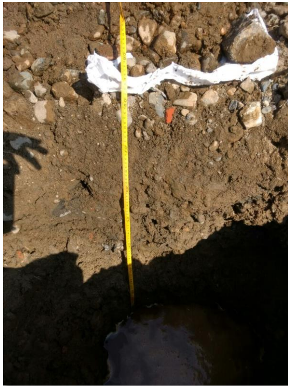
Fotografía de la profundidad alcanzada por la calicata N°1.
