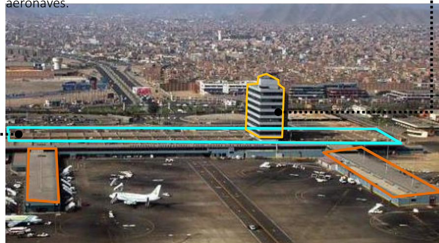
EDIFICIO TERMINAL: Edificio principal de 290.40 m de largo
