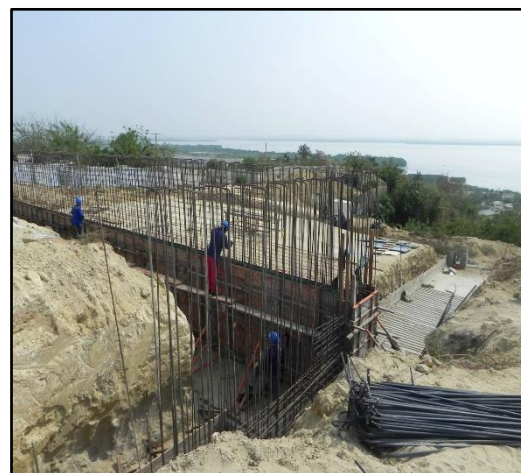
Se construyó muros de concreto armado como también ladrillo
