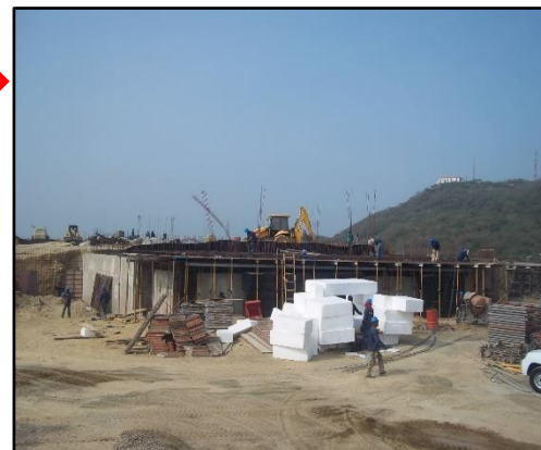
Se construyó muros de concreto armado como también ladrillo
