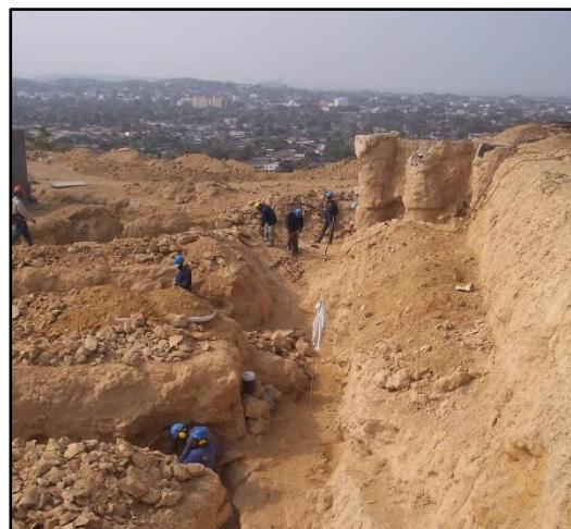
Se hizo el movimiento de tierras para la cimentación
