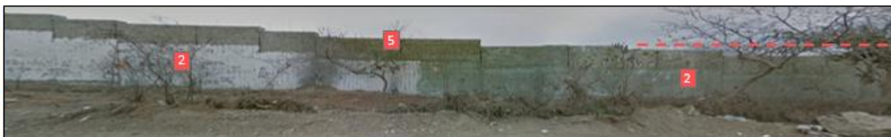
FACHADA LATERA ②
