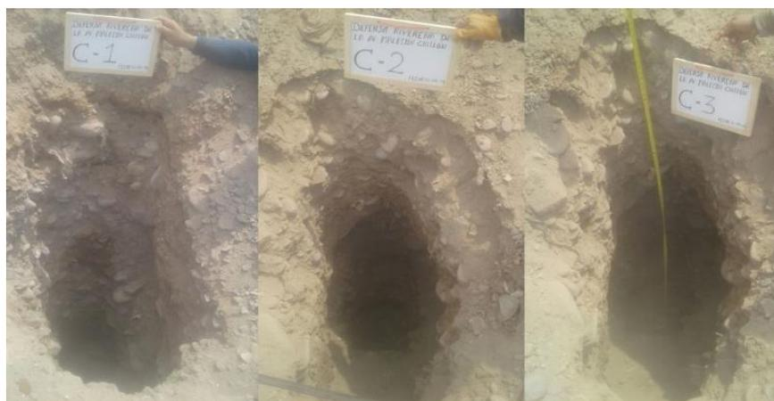
**Figura 23.** Excavación de las tres calicatas. (Fuente: Imagen propia, 2018)
