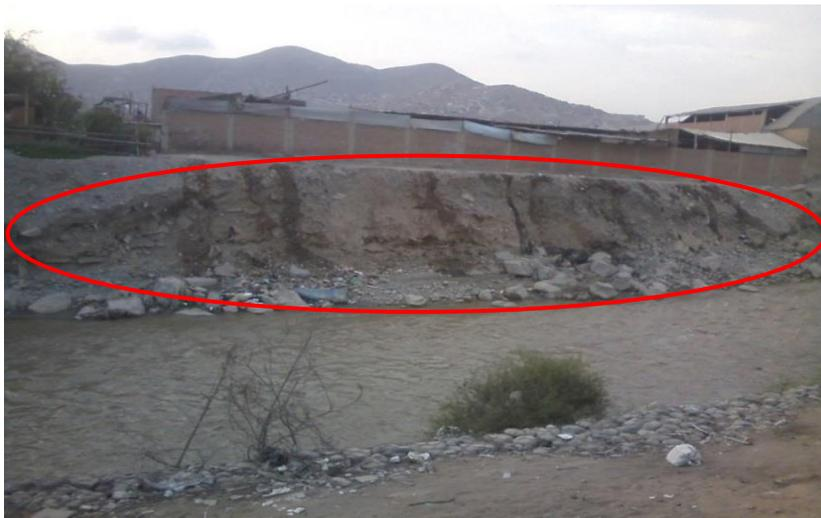
**Figura 19.** Proceso de erosión en la ribera. (Fuente: Imagen propia, 2017)
