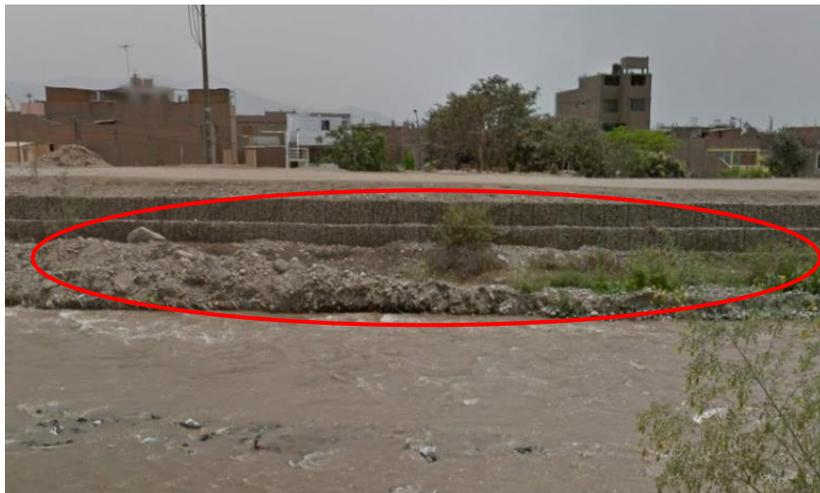
**Figura 21.** Sistemas de protección actual margen izquierda del río.
