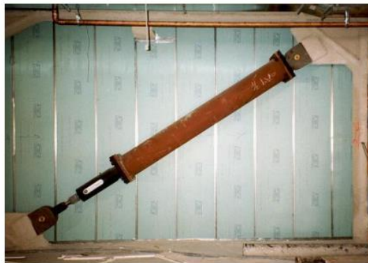
Figura 8. Disposición del disipador tipo diagonal.
