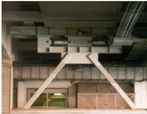
Figura 7. Disposición del disipador tipo chevron.
