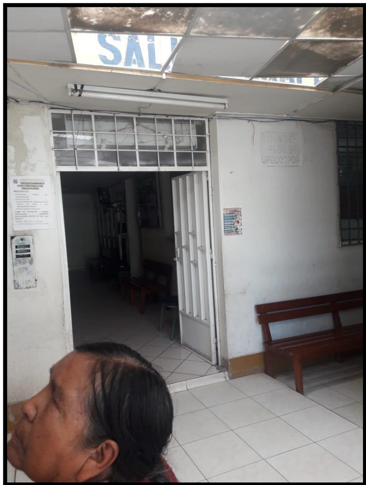
Fotografía 1. Sala de espera en el Centro de Salud “Miraflores”
