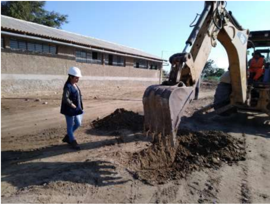
EXCAVACION PARA CALICATA 01 KM. 0+500
