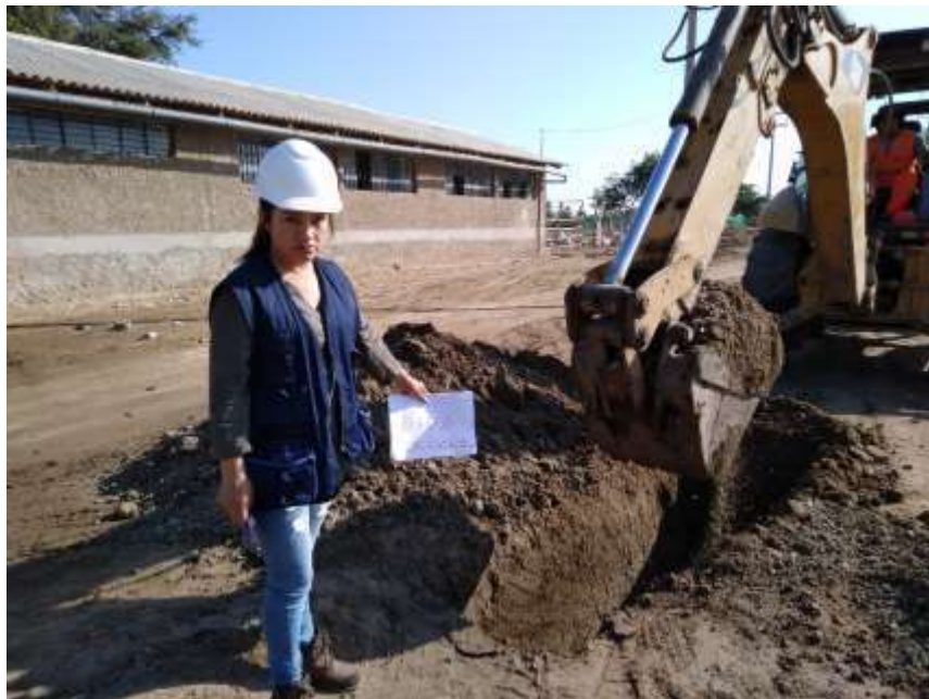
EXCAVACION PARA CALICATA 01 KM. 0+500
