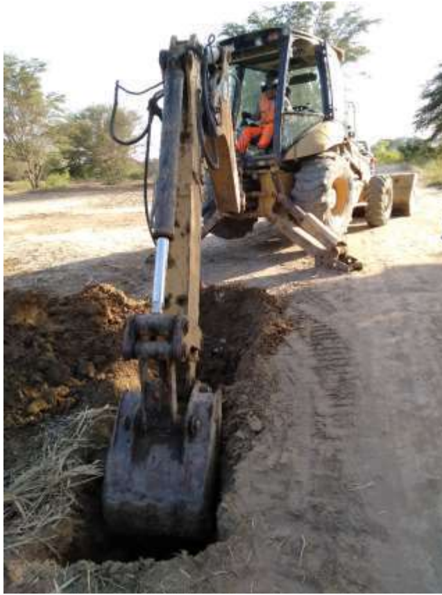
EXCAVACIÓN PARA CALICATA 04 KM. 03+440
