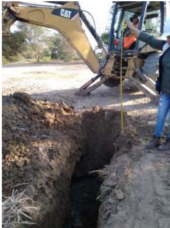
EXCAVACIÓN DE CALICATA 04
