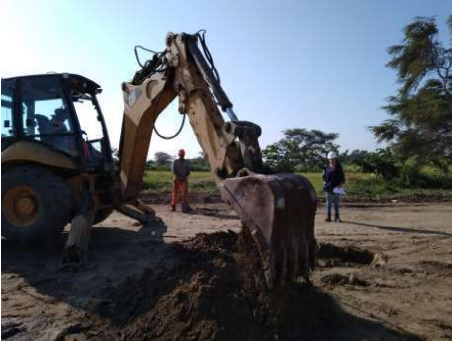
EXCAVACIÓN PARA CALICATA 02 KM. 01+460
