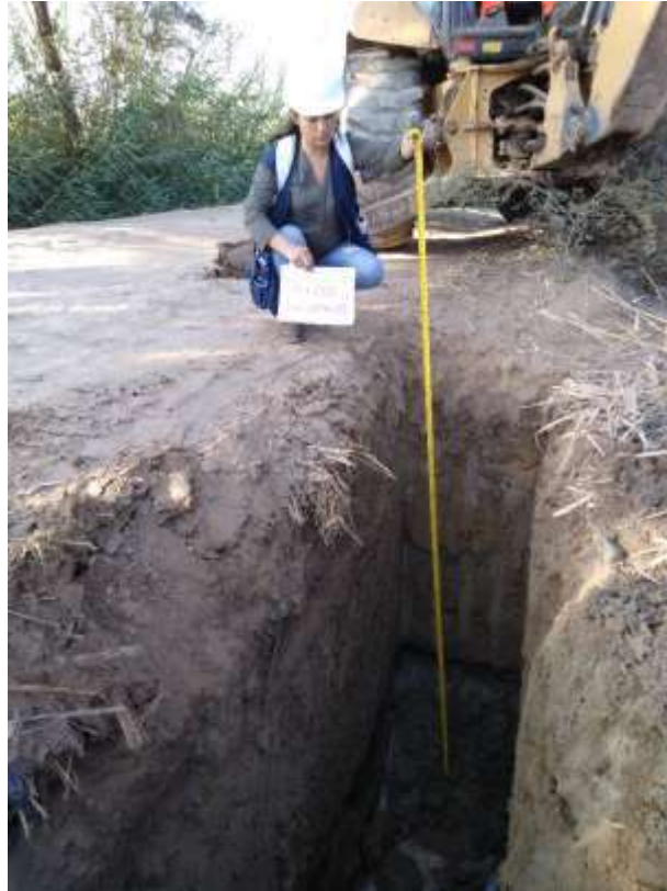
EXCAVACIÓN DE CALICATA 05 KM. 04+400
