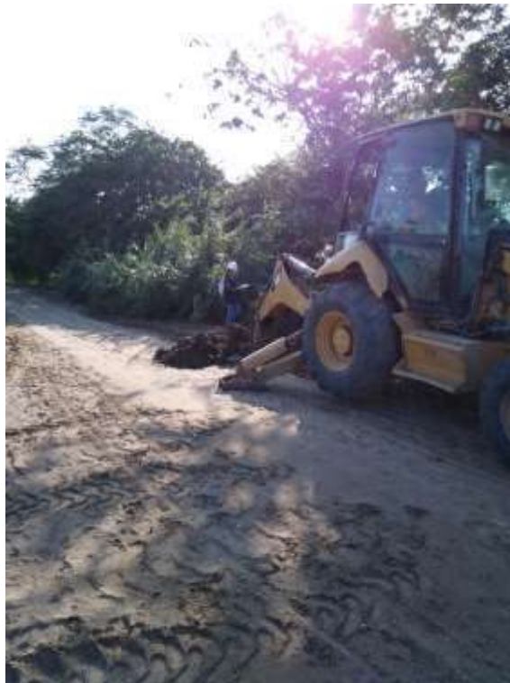
EXCAVACIÓN PARA CALICATA 03 KM. 02+500
