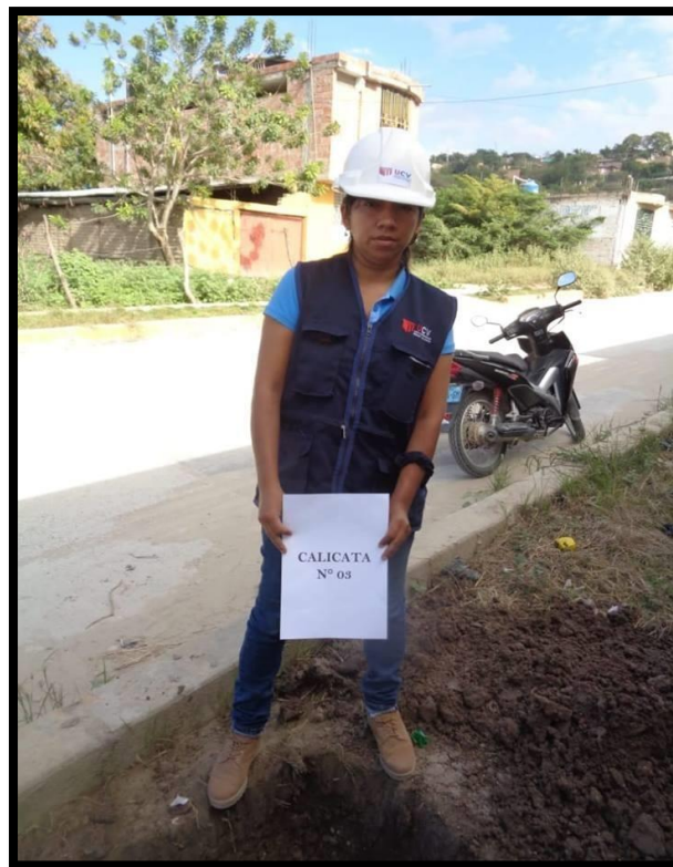
FOTO N° 10: Sacando las muestras de calicatas para la mecánica de suelo.
