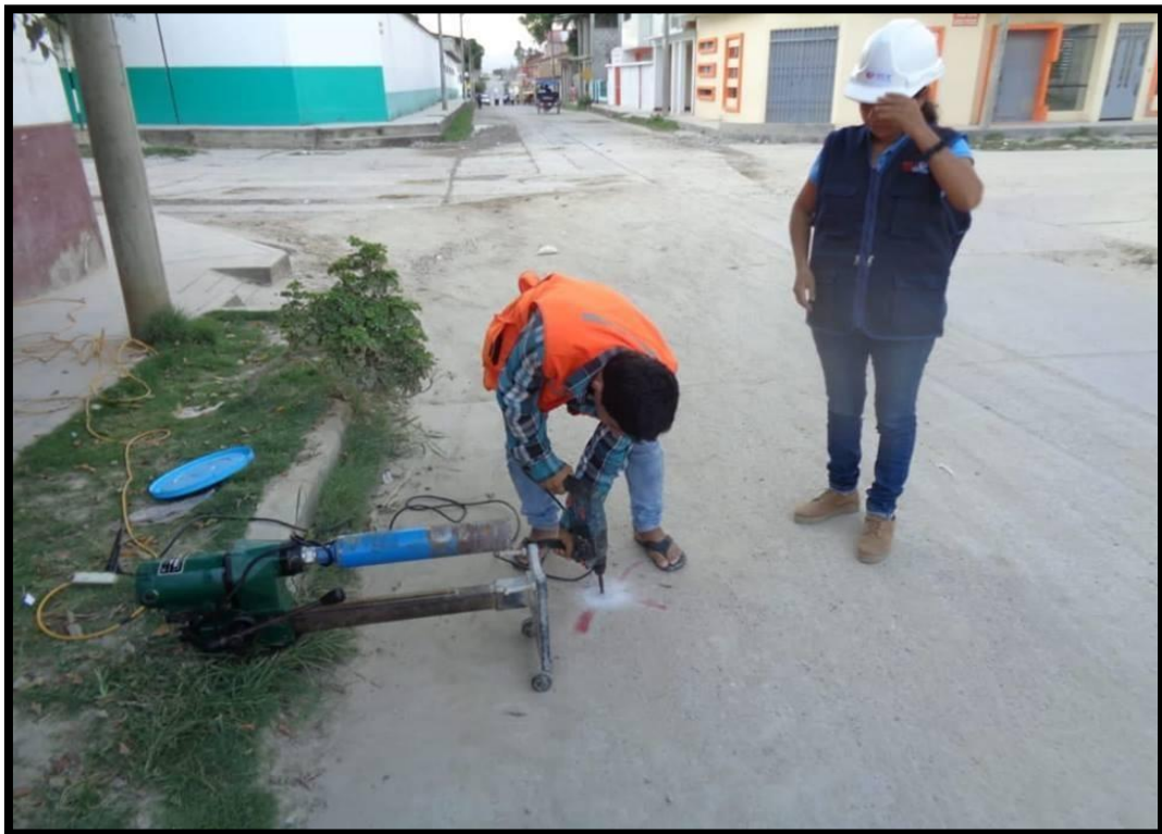
FOTO N° 12: Señalando los puntos para sacar la muestra de la diamantina.
