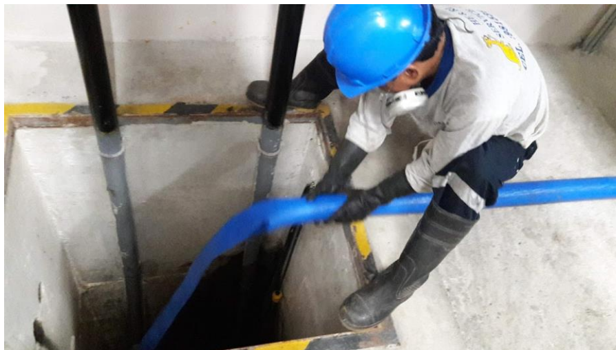
Figura 71. Retiro del agua de la cisterna contra incendio al pozo séptico
