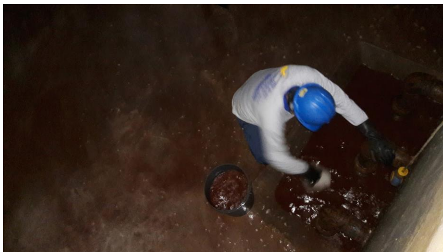
Figura 93. Enjuague y retiro de agua sucia de cisterna
