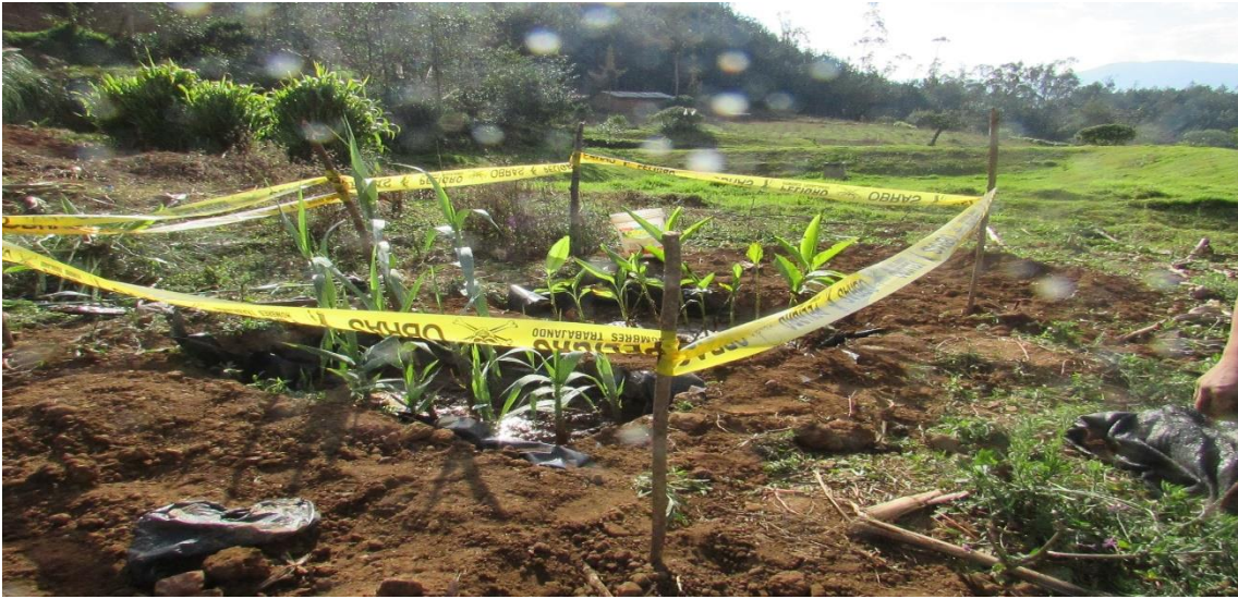
Humedal en los primeros días de instalado
