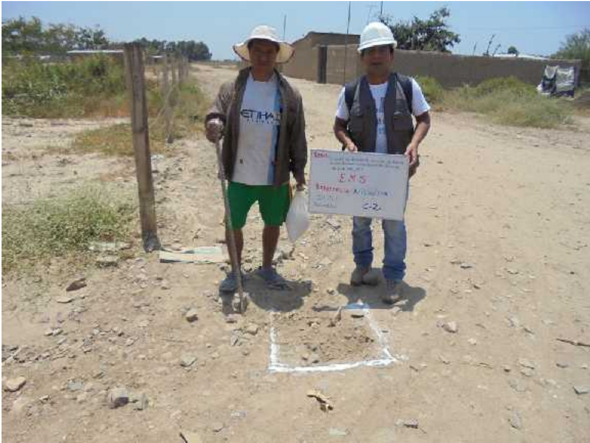
Foto 3: Registro de Exploración en C-2
