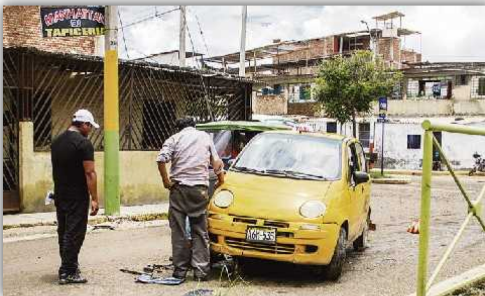
Figura 2. Mal estado de las calles de Piura.
