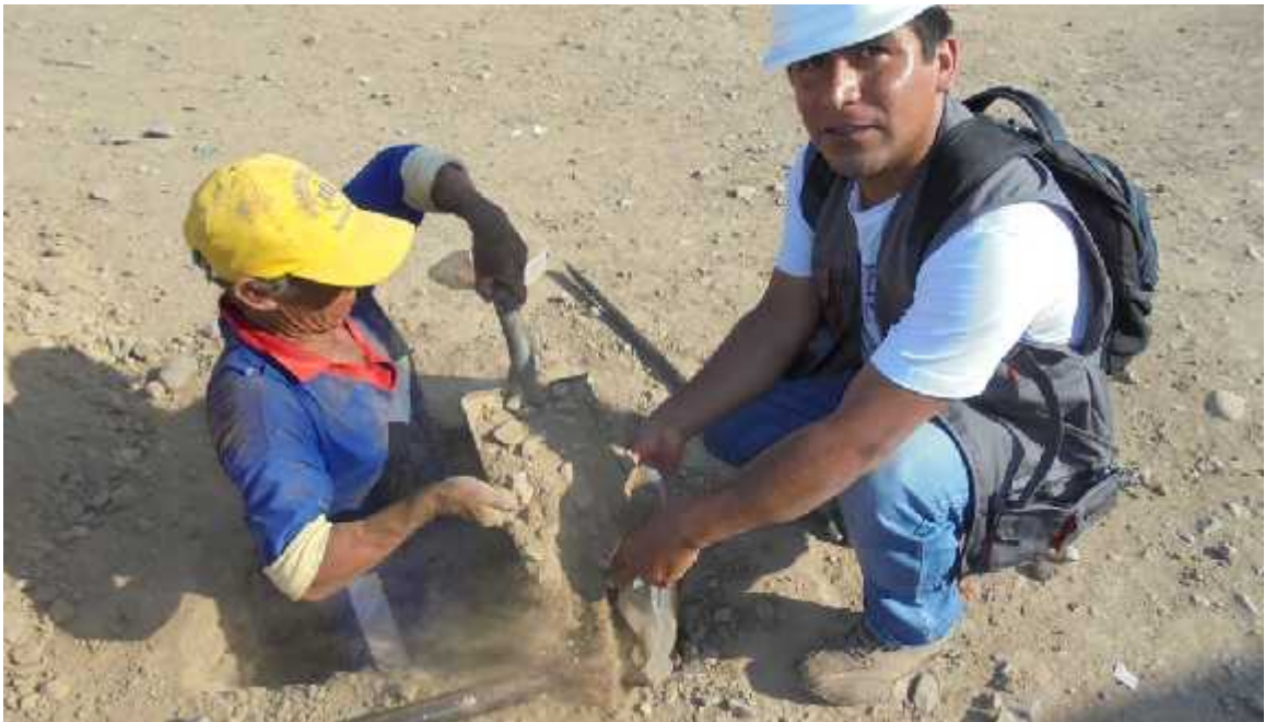
Foto 6: Registro de Exploración en C-3
