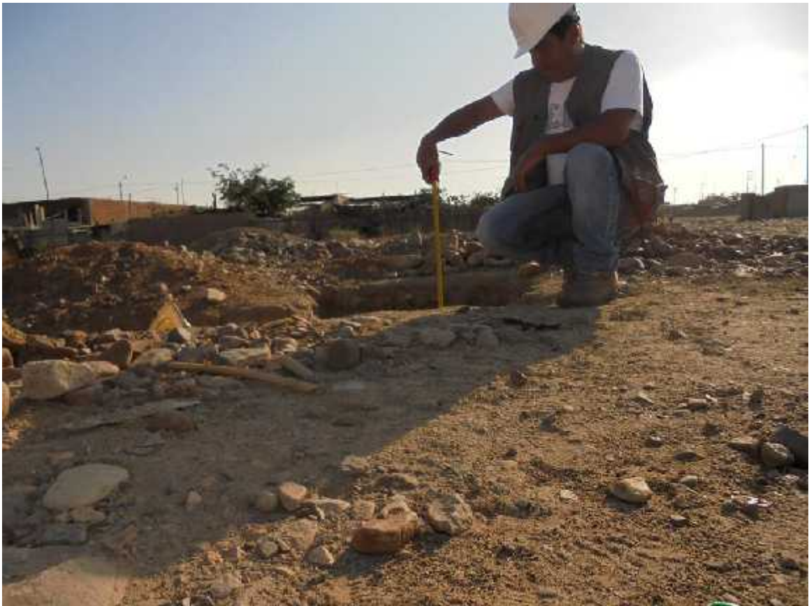
Foto 10: Registro de Exploración en C-5
