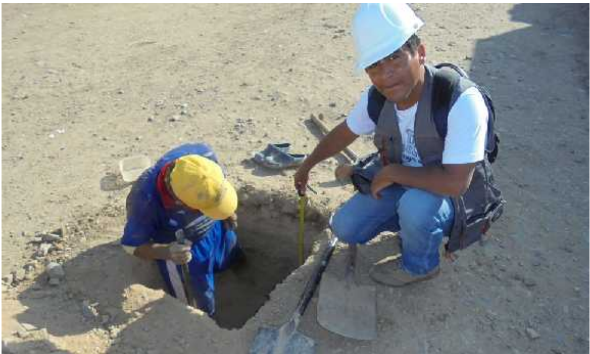
Foto 2: Registro de Exploración en C-1
