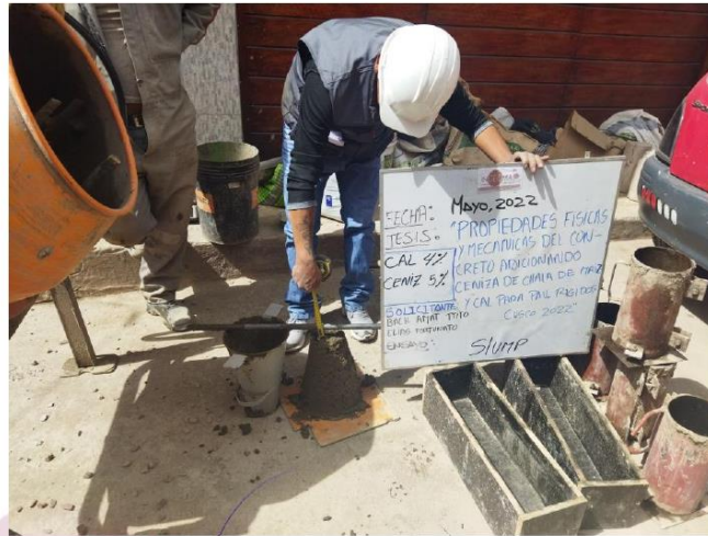
Fotografía 1 y Fotografía 2 Determinación del SLUMP.
