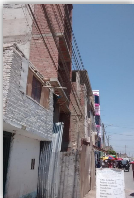
FIGURA 13: VISTA EXTERIOR DE PERFIL: LOS CABLES DE BT (BAJA TENSIÓN) ESTÁN ROSANDO LA FACHADA DEL EDIFICIO MULTIFAMILIAR
