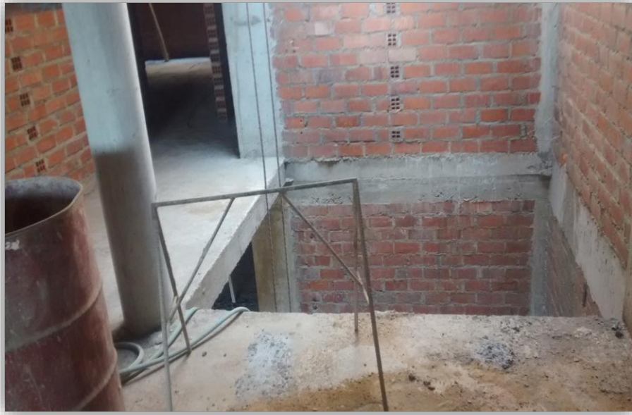
FIGURA 17: FALTA ORDEN, EL CABLEADO Y MANGUERAS CUELGAN SIN PROTECCIÓN
