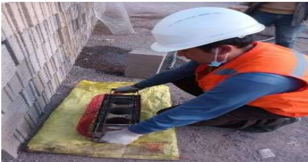
Figura 10. Fabricación de bloques de concreto con relave minero
