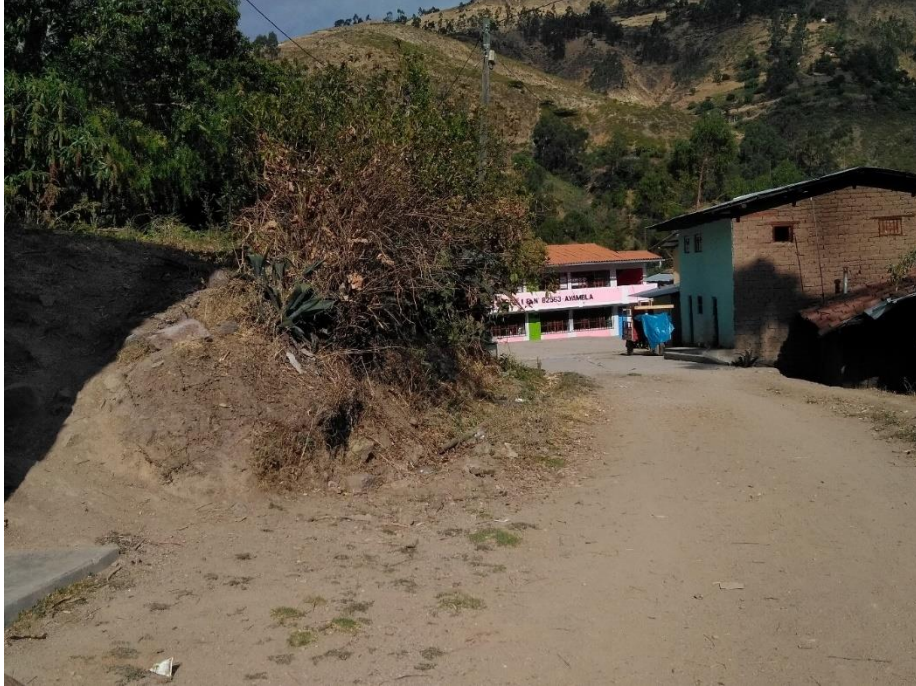
FOTO 11: Presencia de derrumbes en la zona
