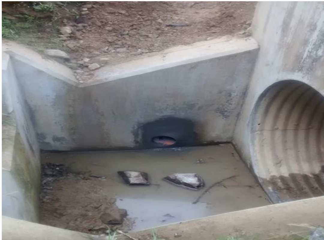
Fotografía N° 25 – Evaluación de alcantarillas y sub-dren, Km. 98+600
