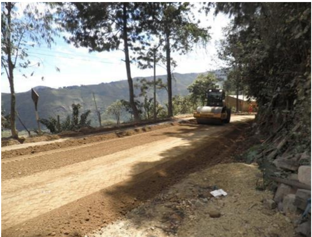
Fotografía N° 17 – Compactación de Base estabilizada, Km. 84+600
