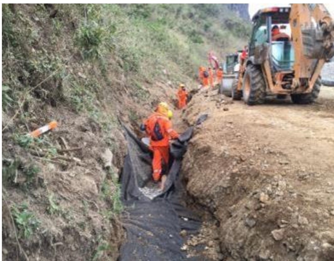
Fotografía N° 24 – Conformación de Sub-dren, Km. 98+200
