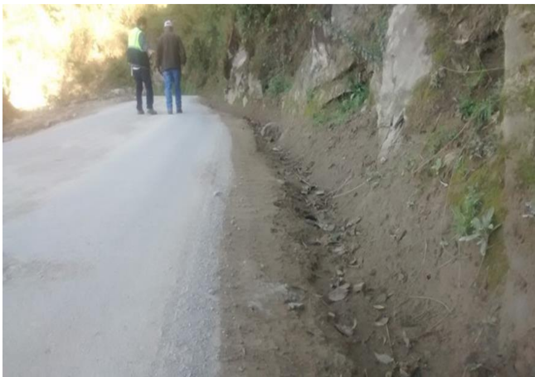
Fotografía N° 4 – Evaluación superficial de pavimento, Km. 97+400
