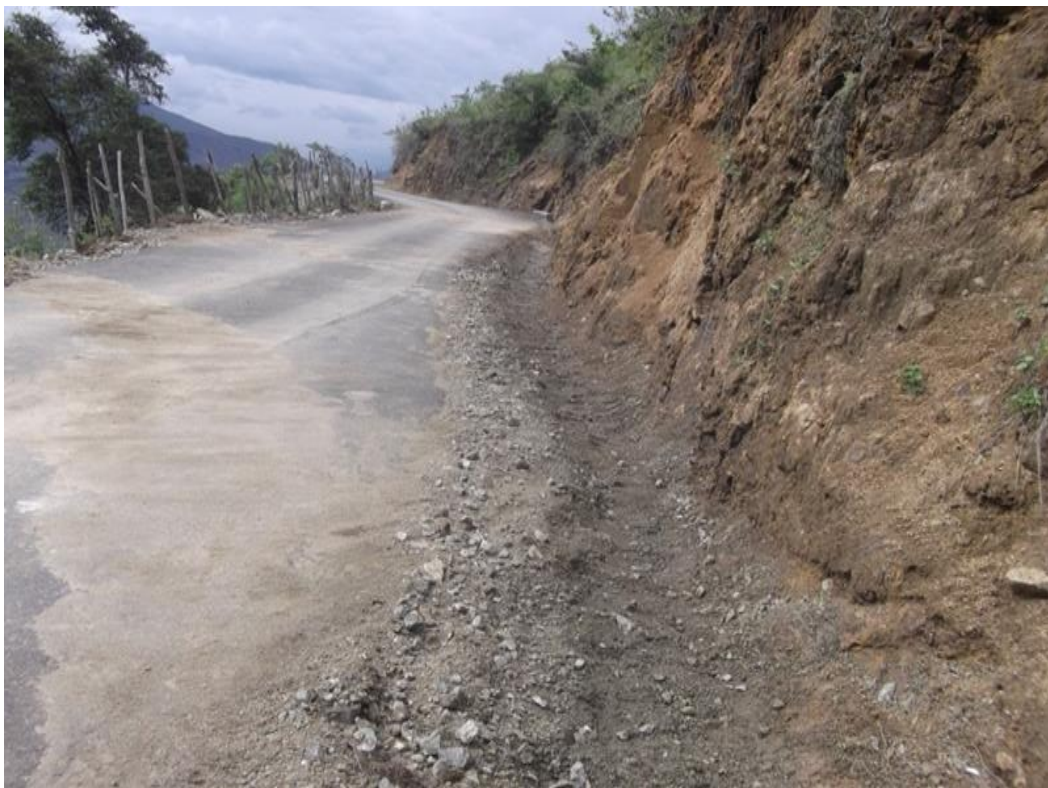
Fotografía N° 23 – Vista Después del mantenimiento de cunetas, Km. 104+800
