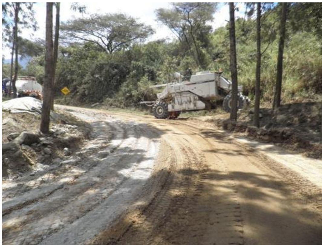
Fotografía N° 15 - Aplicación de aditivo Proes para Base estabilizada, Km 83+200
