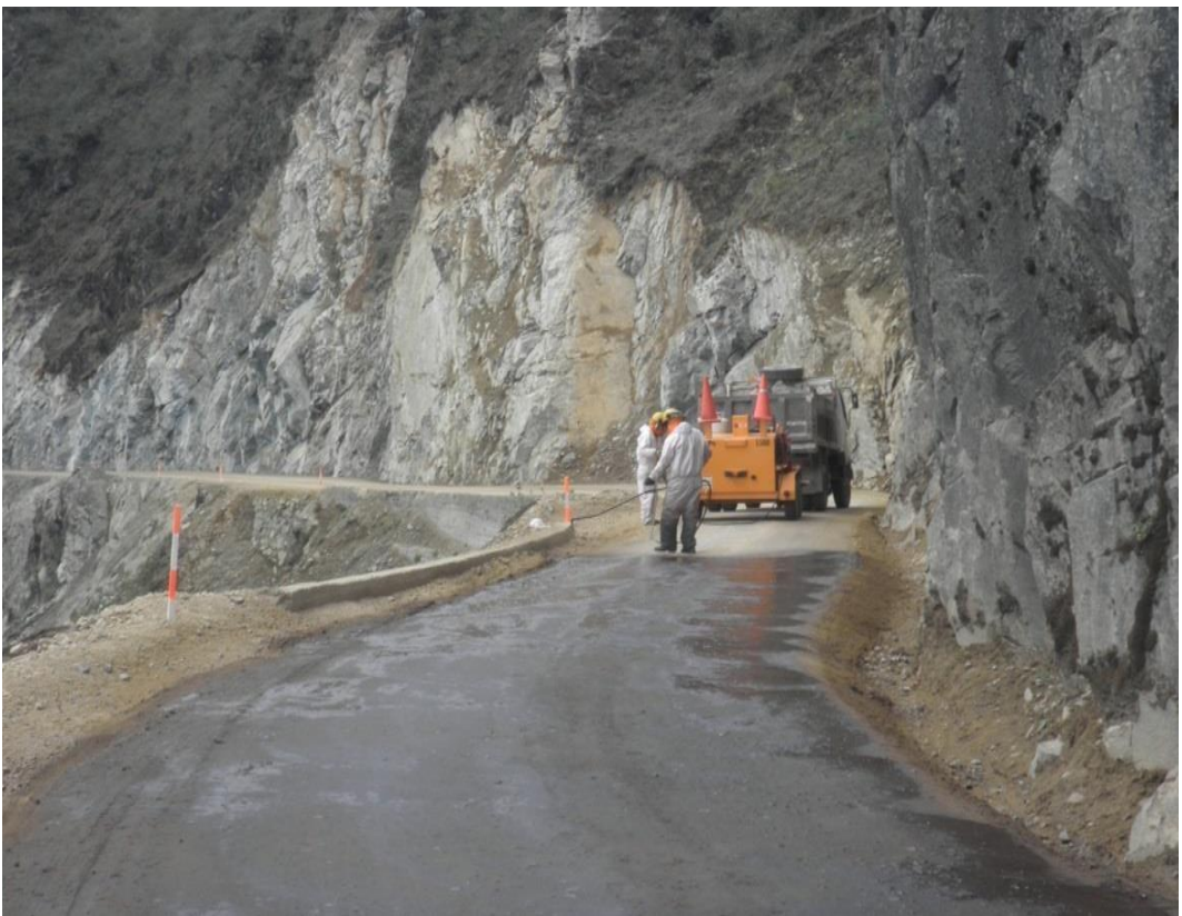
Fotografía N° 19 – Trabajos de Imprimación, Km. 94+800
