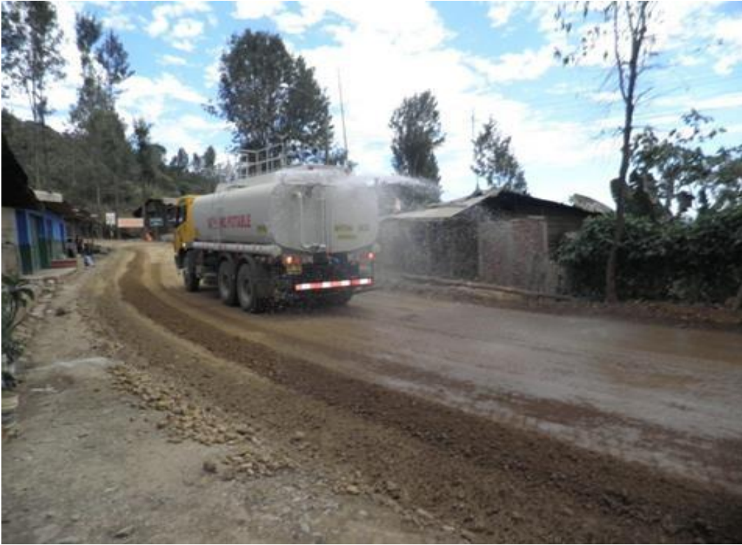
Fotografía N° 19 – Trabajos de Imprimación, Km. 94+800
