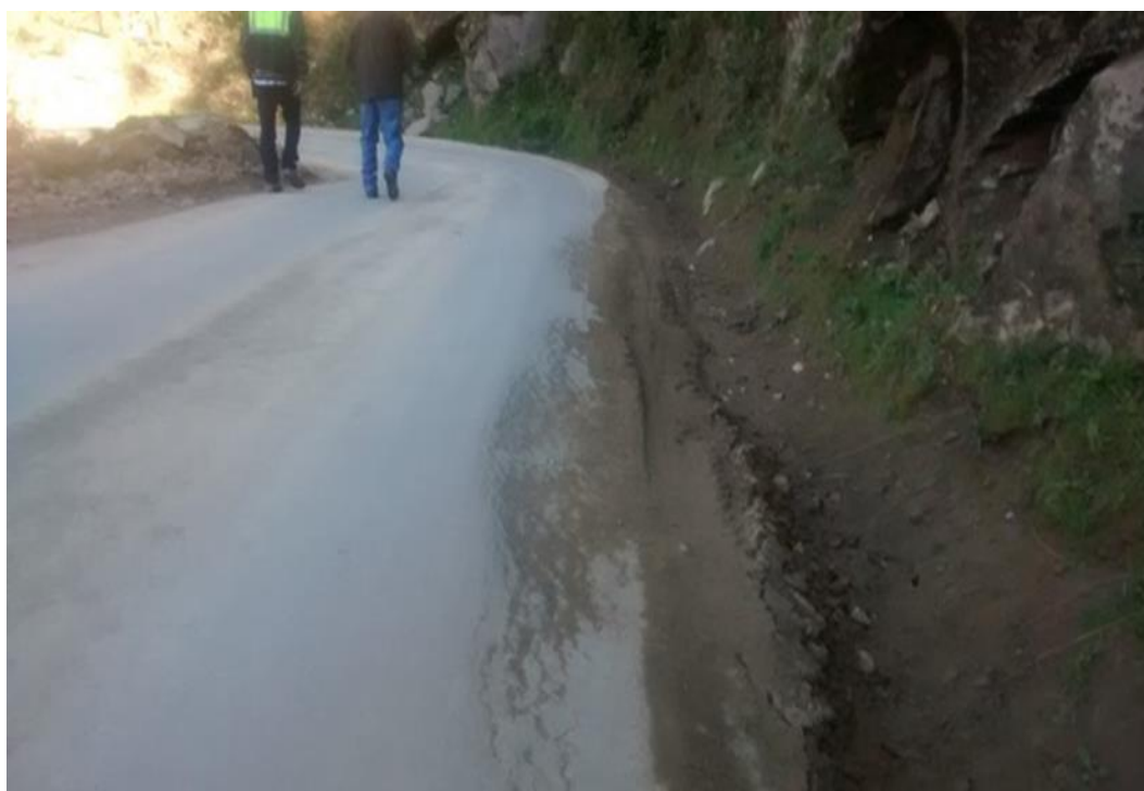
Fotografía N° 2 – Presencia de fallas prematuras en pavimento
