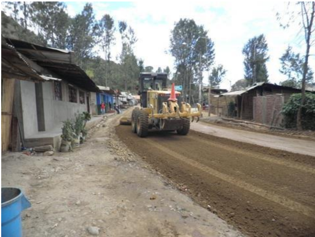
Fotografía N° 17 – Compactación de Base estabilizada, Km. 84+600
