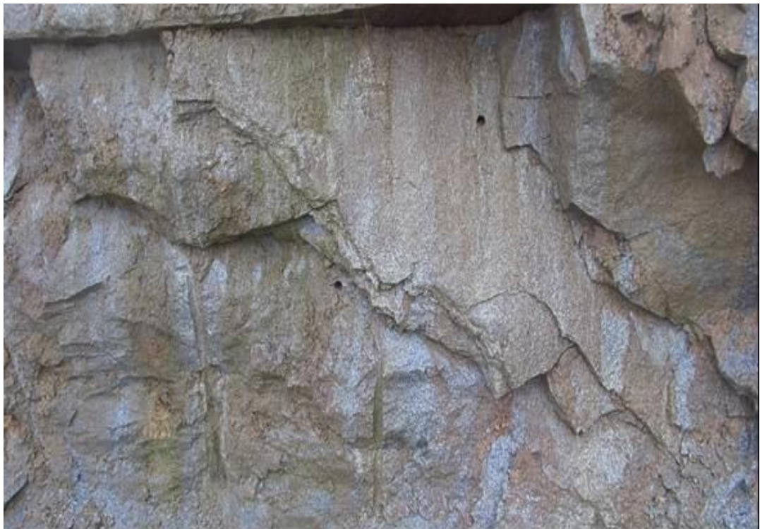
Fotografía N° 13 – Afloramientos rocosos en talud de corte, Km 93+300
