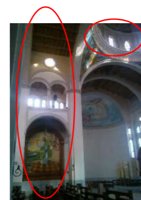
Ventanas en el corredor del 2° piso
