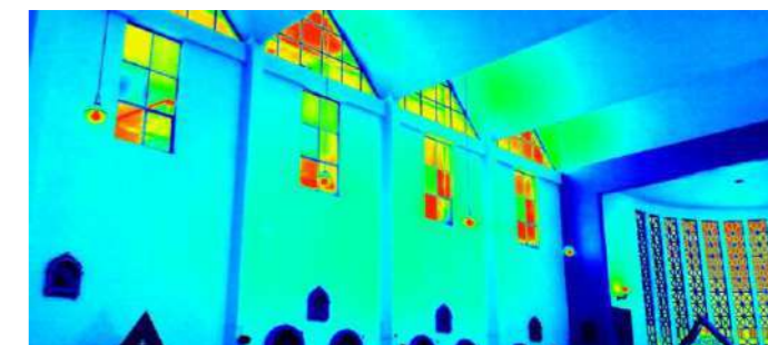
D. MURO LATERAL
