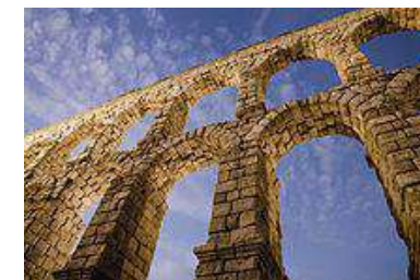
Vista desde los pilares de la arquería del acueducto
