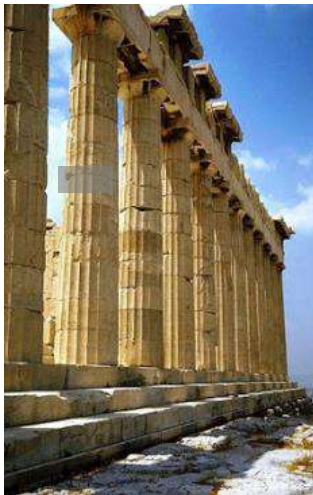
Fig.N°26 Columnas Construidas mediante bloques de tambores
