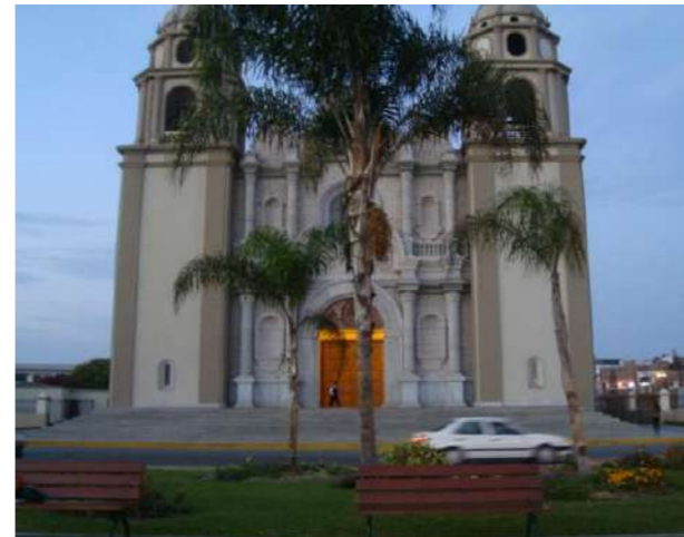
Fig. N°11 VISTA EXTERIOR- FACHADA FRONTAL
