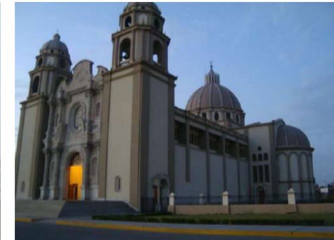
Fig. N°12 VISTA EXTERIOR- FACHADA LATERAL 1
