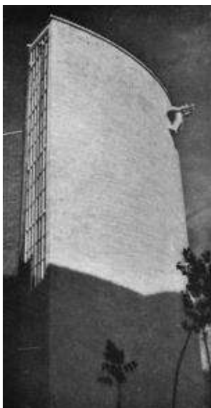
Fig. N° 41 Fachada de la Iglesia
