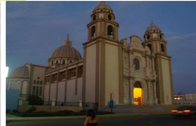
Fig. N°14 VISTA EXTERIOR- FACHADA FRONTAL
