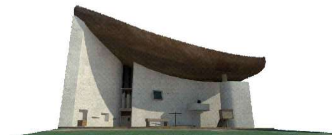
Fachada Este direccional.
