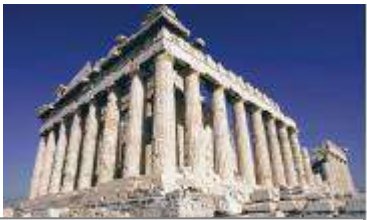
Fig. 10. Vista exterior del Partenón en Atenas, Grecia (447-432 a. C.)
