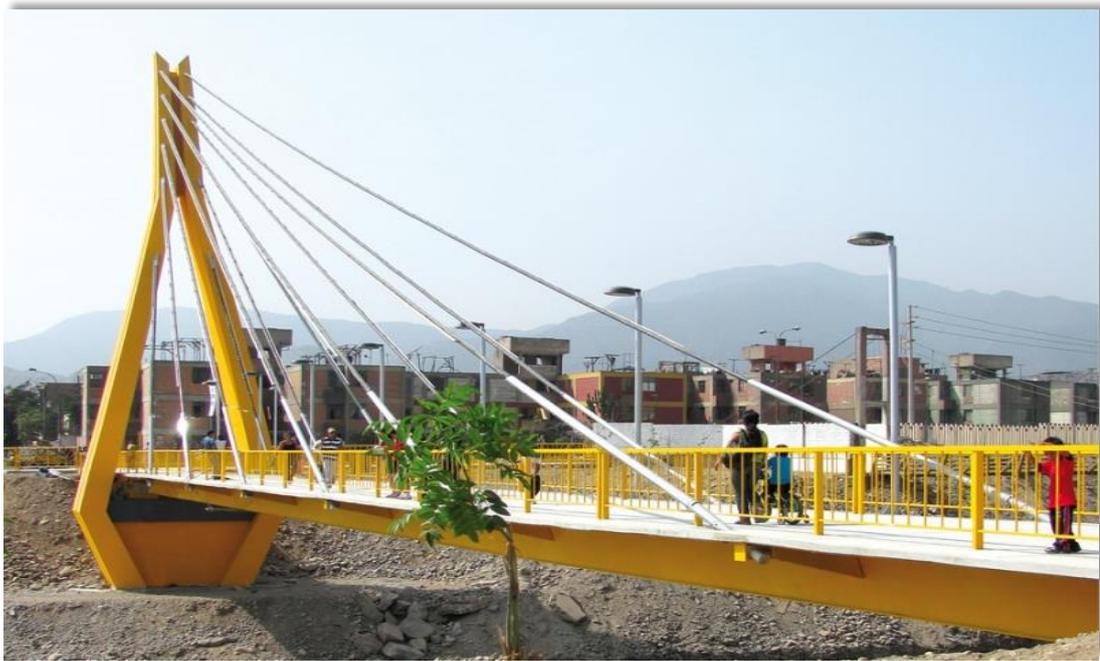
*Figura 1.13.* Puente peatonal atirantado de una sola torre, construccióny vivienda, 2016.
