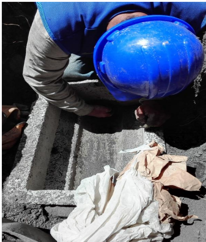
Foto N° 16 | Operario colocando la caja de registro en la vivienda.
