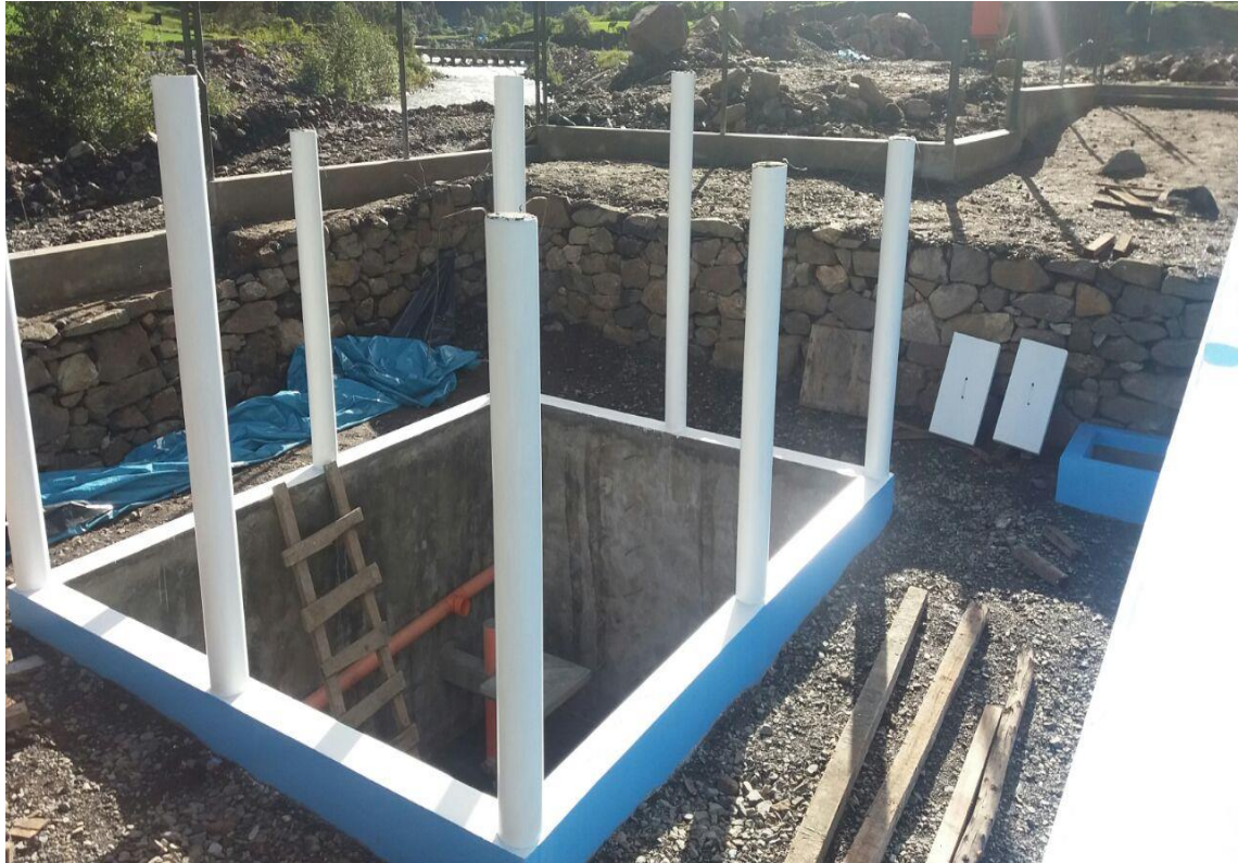
Foto N° 34 | Construcción del lecho de secado de la planta de tratamiento.
