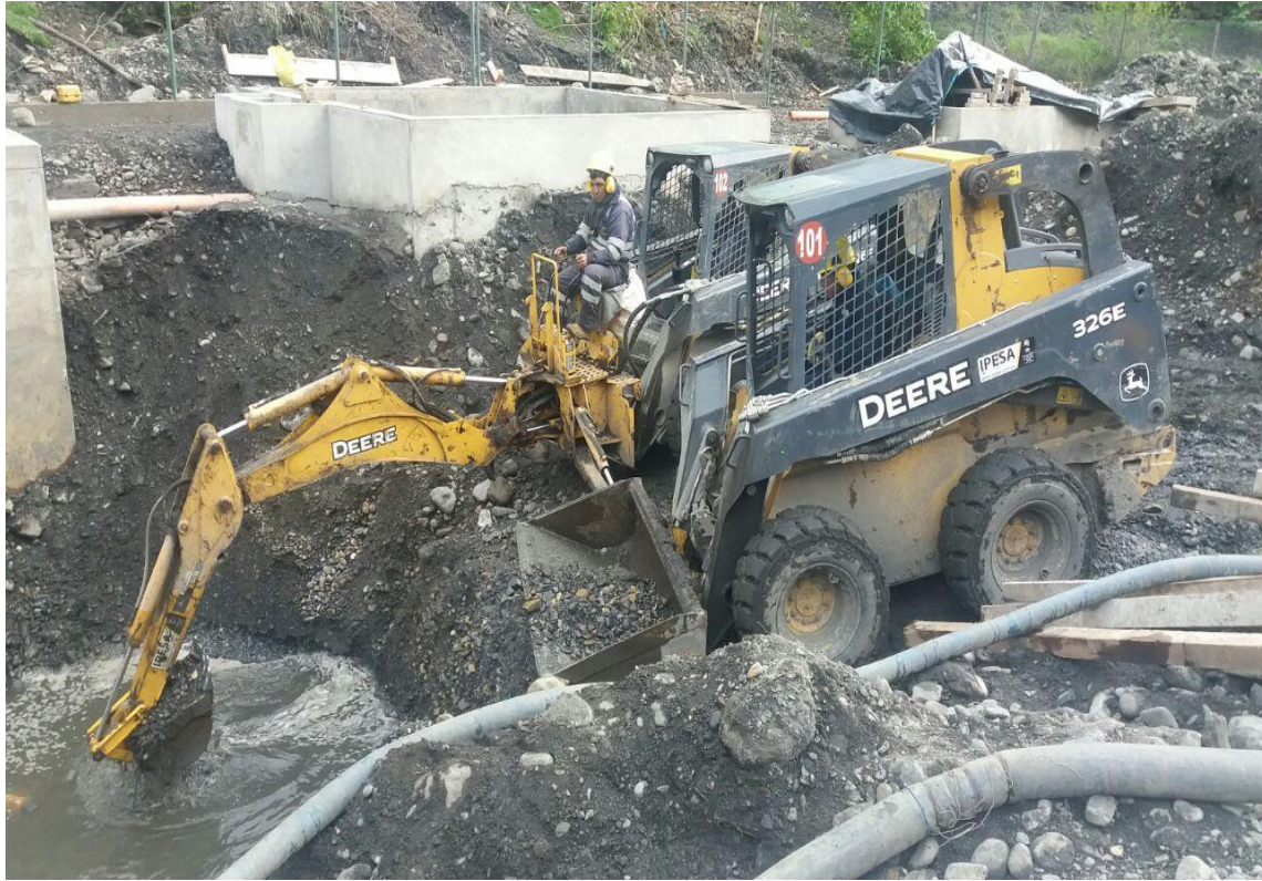
Foto N° 33 | Excavación con la retroexcavadora para la planta de tratamiento.
