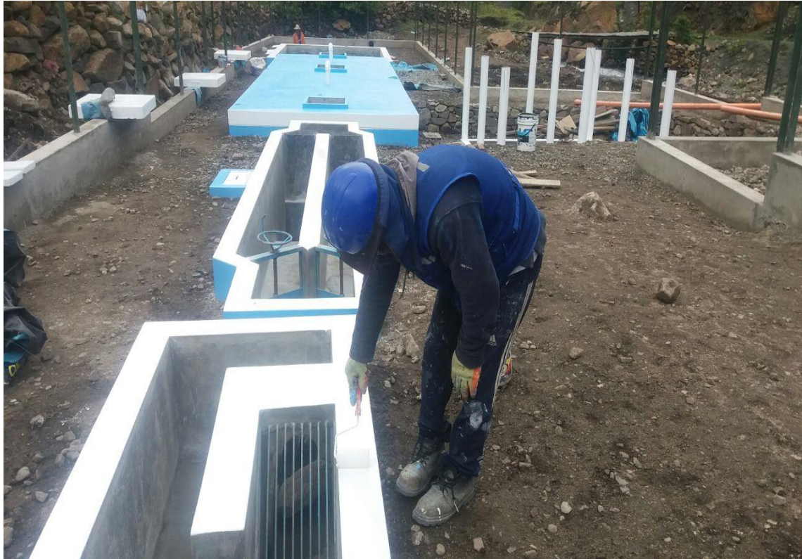
Foto N° 32 | Pintado de la cámara de rejas de la planta de tratamiento de aguas residuales.
