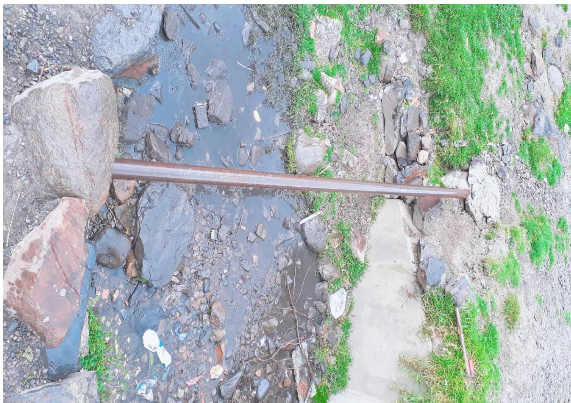
Foto N° 42 | Pase aéreo en la localidad de Quitaracsa.
