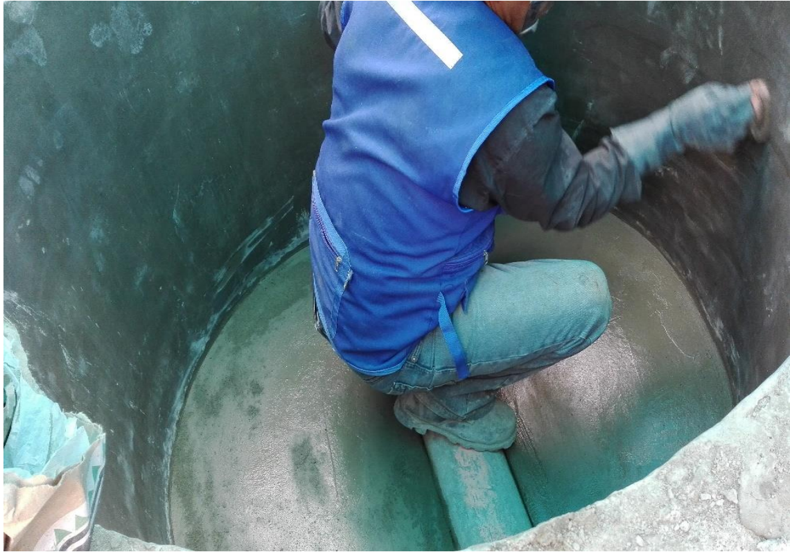
Foto N° 19 | Solaqueado interior del cuerpo de la cámara de inspección.
