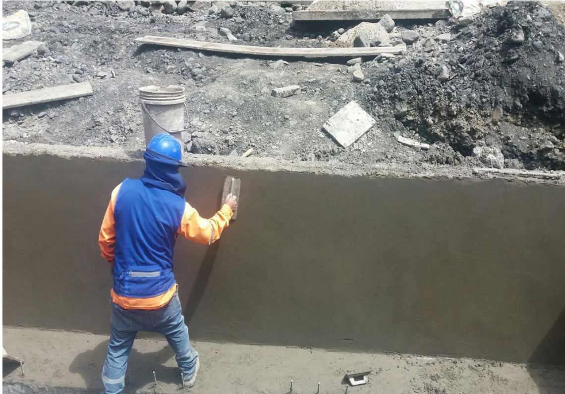
Foto N° 36 | Trabajo de tarrajeo en las paredes de los muros.
