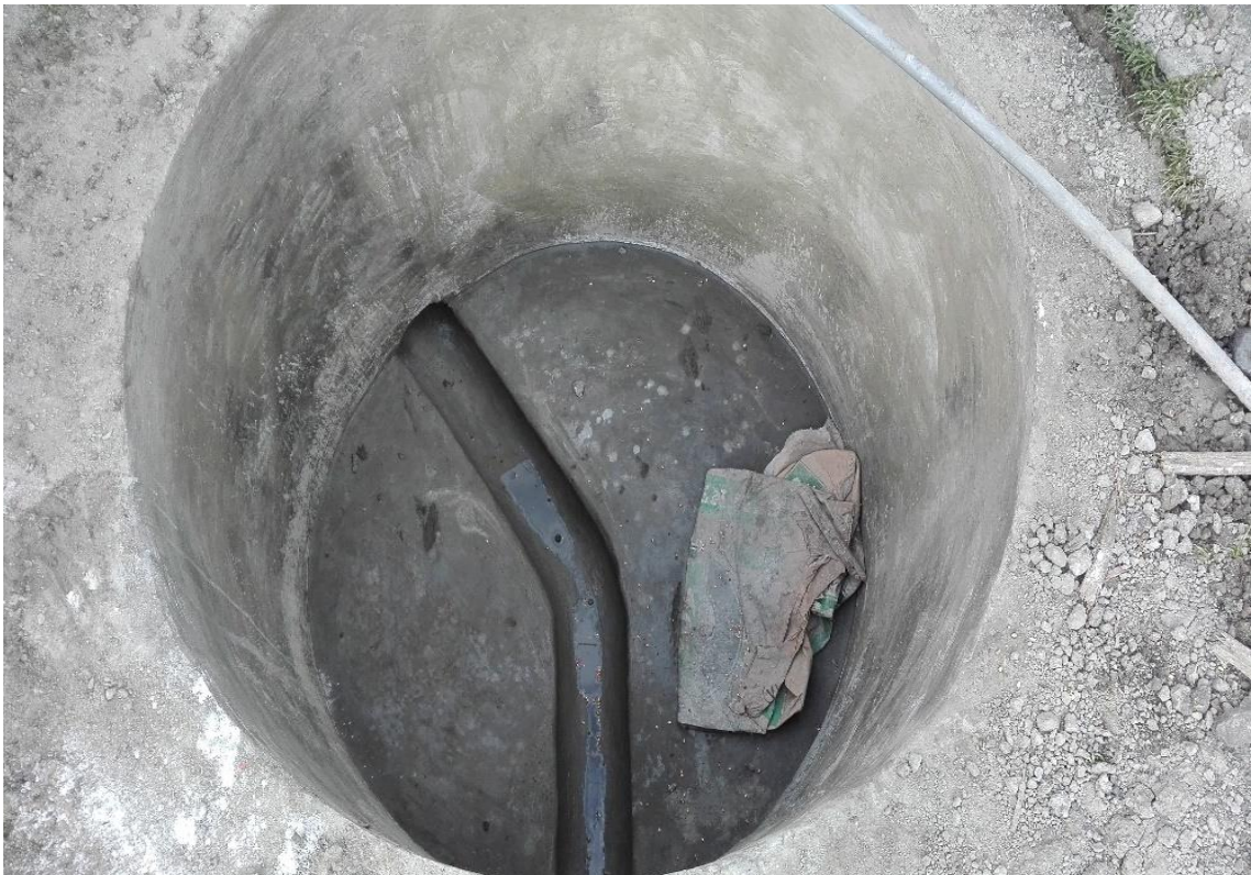
Foto N° 12 | Media caña en el fondo de la cámara de inspección.
