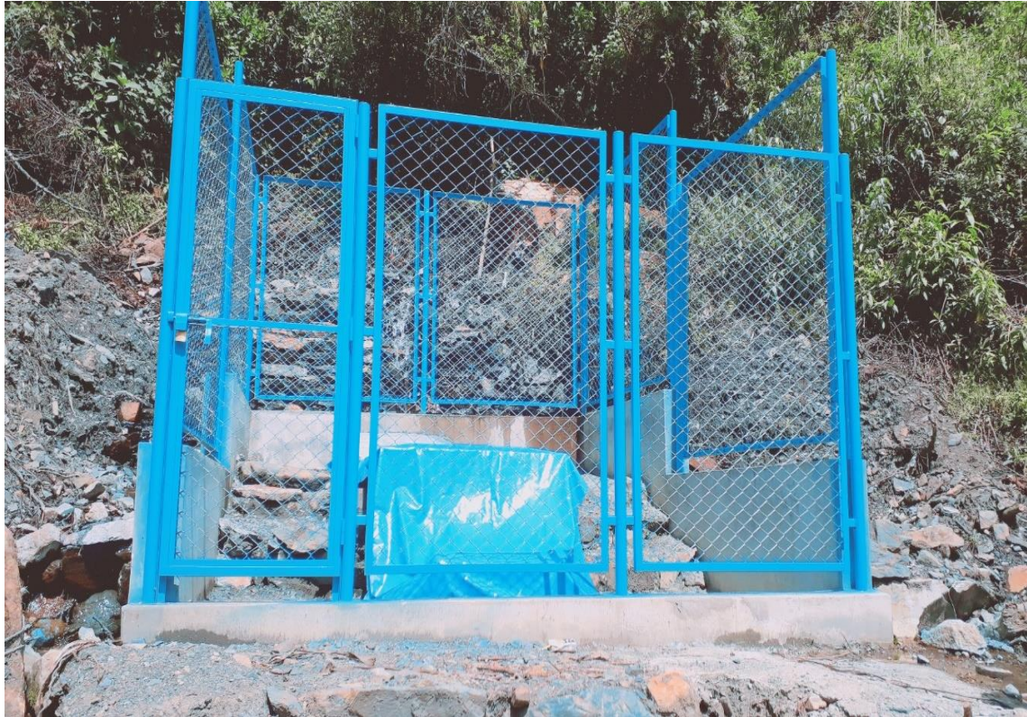
Foto N° 45 | Captación en la localidad de Quitaracsa.
