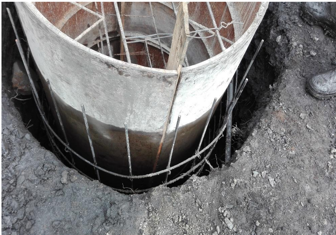
Foto N° 18 | Molde y malla de acero para la cámara de inspección.
