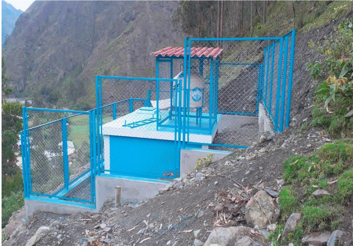
Foto N° 41 | Reservorio de almacenamiento en la localidad de Quitaracsa.
