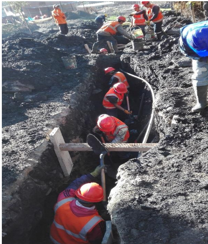
Foto N° 10 | Trabajos de excavación de zanja para el sistema de desagüe.
