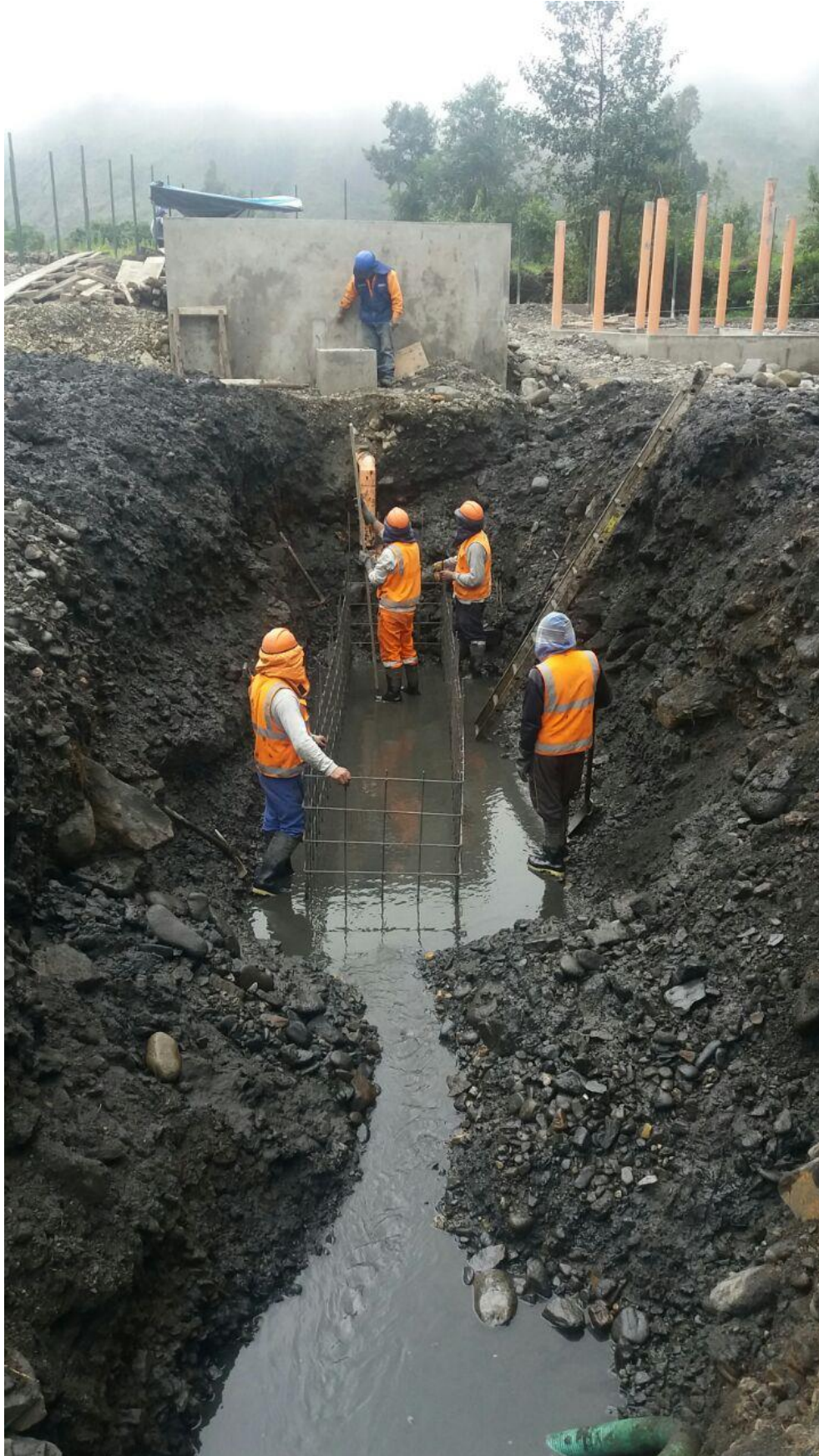
Foto N° 25 | Colocación de las mallas de acero para el pozo de percolación.
