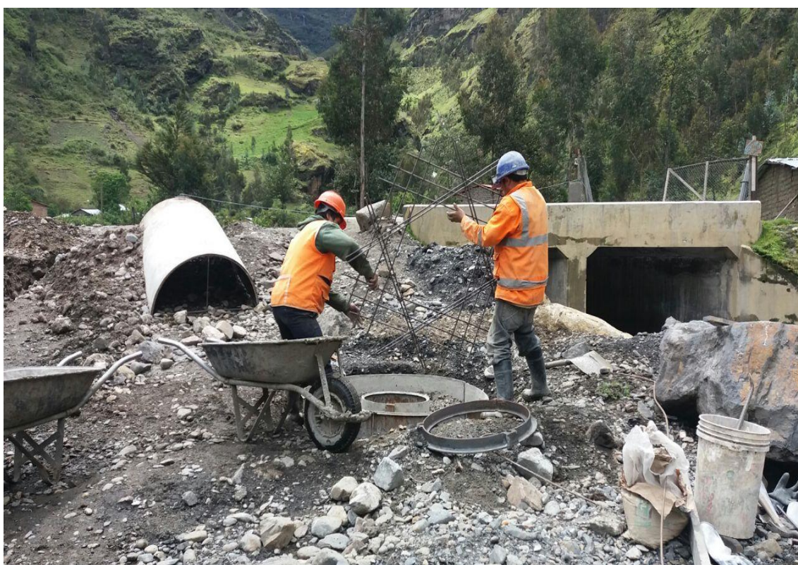
Foto N° 28 | Colocación de la armadura de acero para la tapa del buzón.
