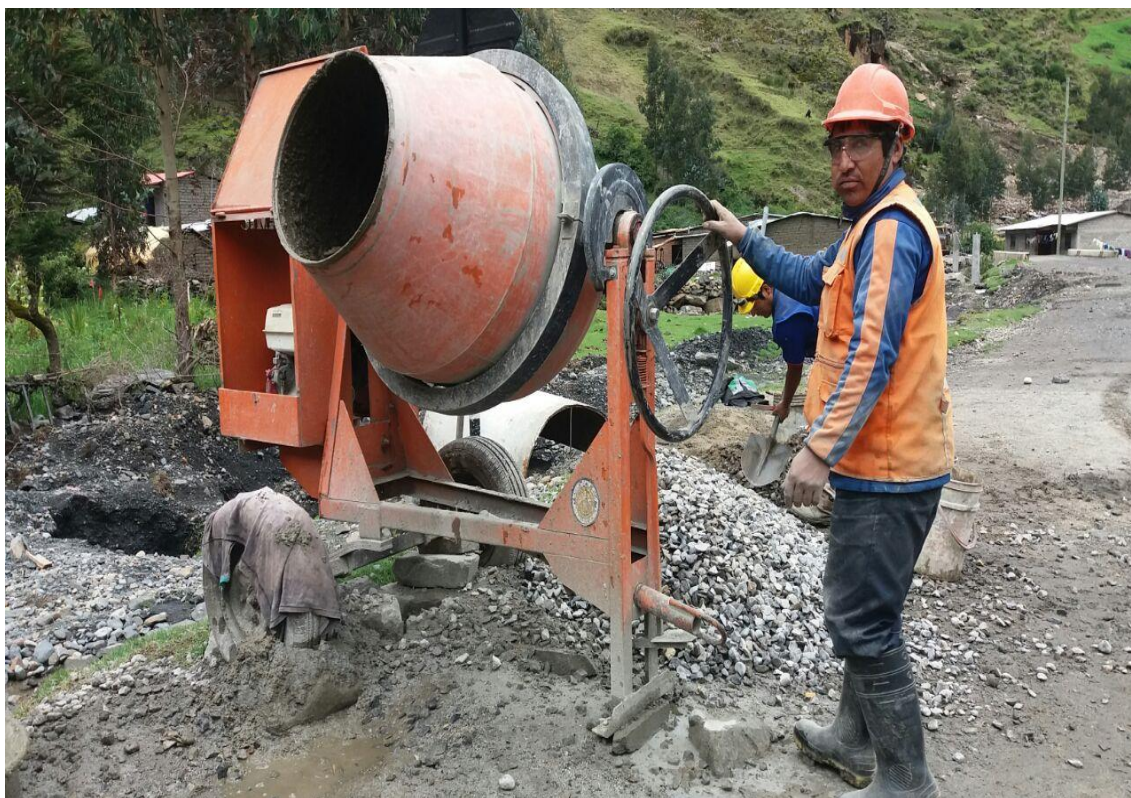
Foto N° 27 | Mezcla del concreto con el trompo para vaciado de buzones.
