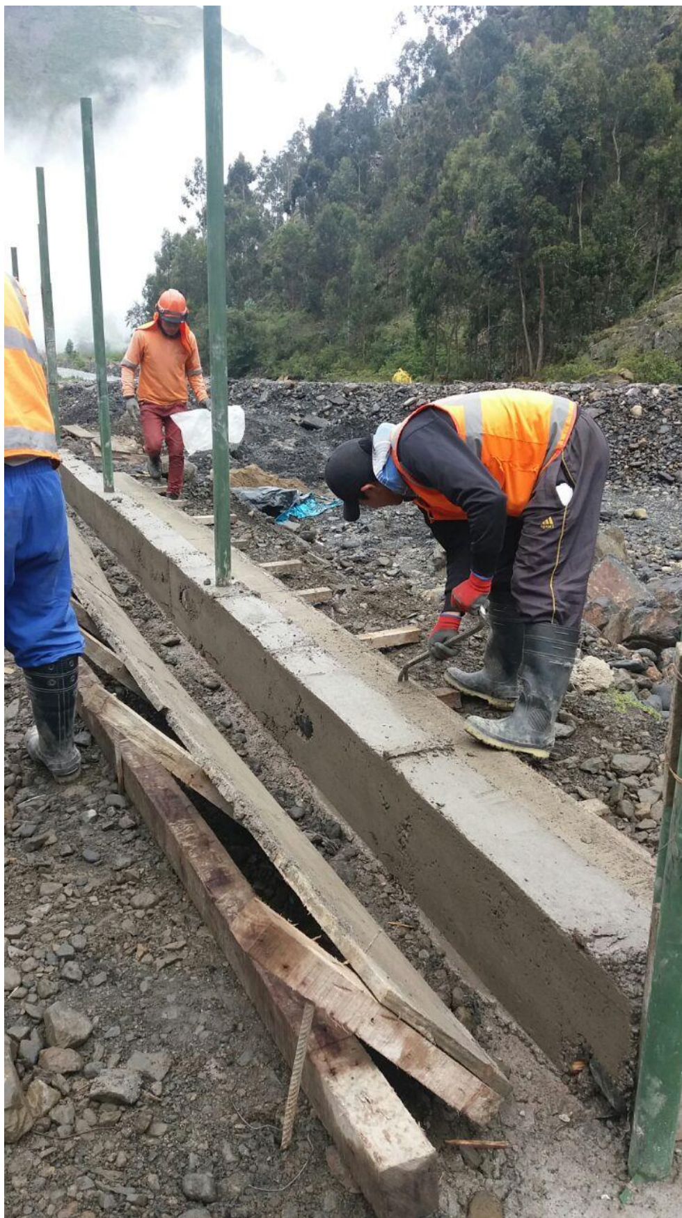
Foto N° 26 | Desencofrado del cerco perimétrico.
