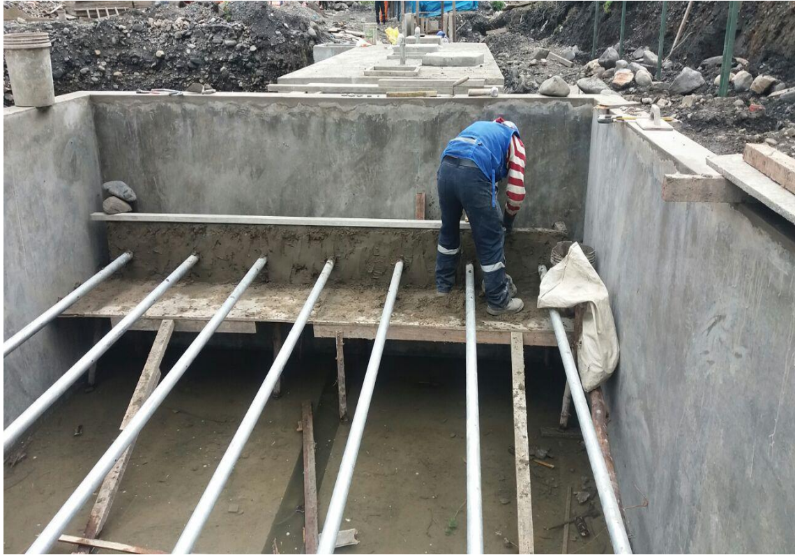
Foto N° 31 | Construcción de la caja de distribución de la planta de tratamiento.
