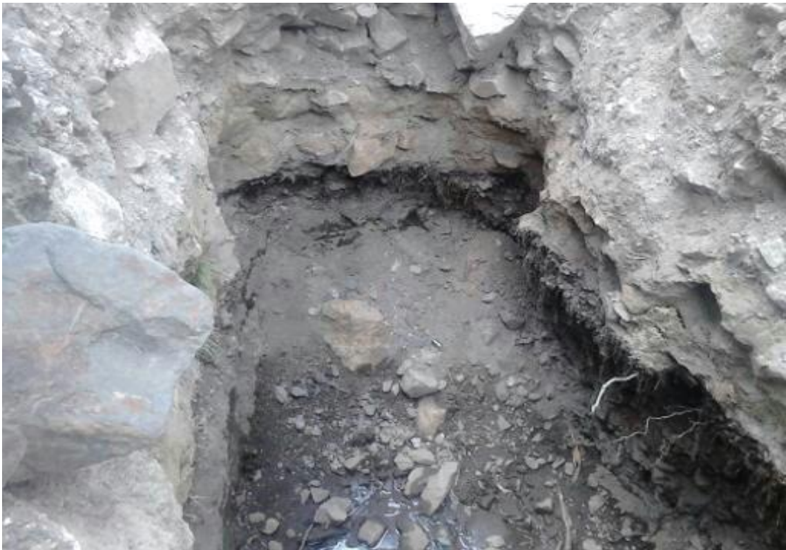
Foto N° 08 | Calicata en la planta de tratamiento para el estudio de suelos.
