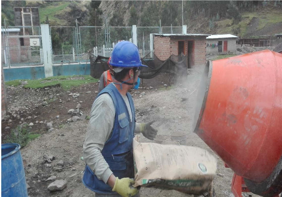
Foto N° 14 | Operario mezclando los materiales utilizando el equipo de protección.
