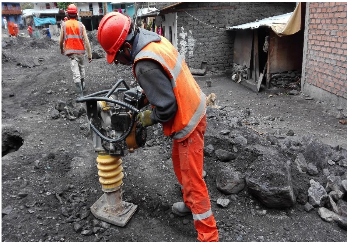
Foto N° 20 | Compactación del terreno luego del relleno.
