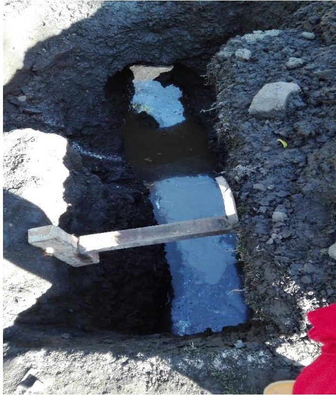
Foto N° 09 | Entibado para evitar el deslizamiento en la excavación de zanja.
