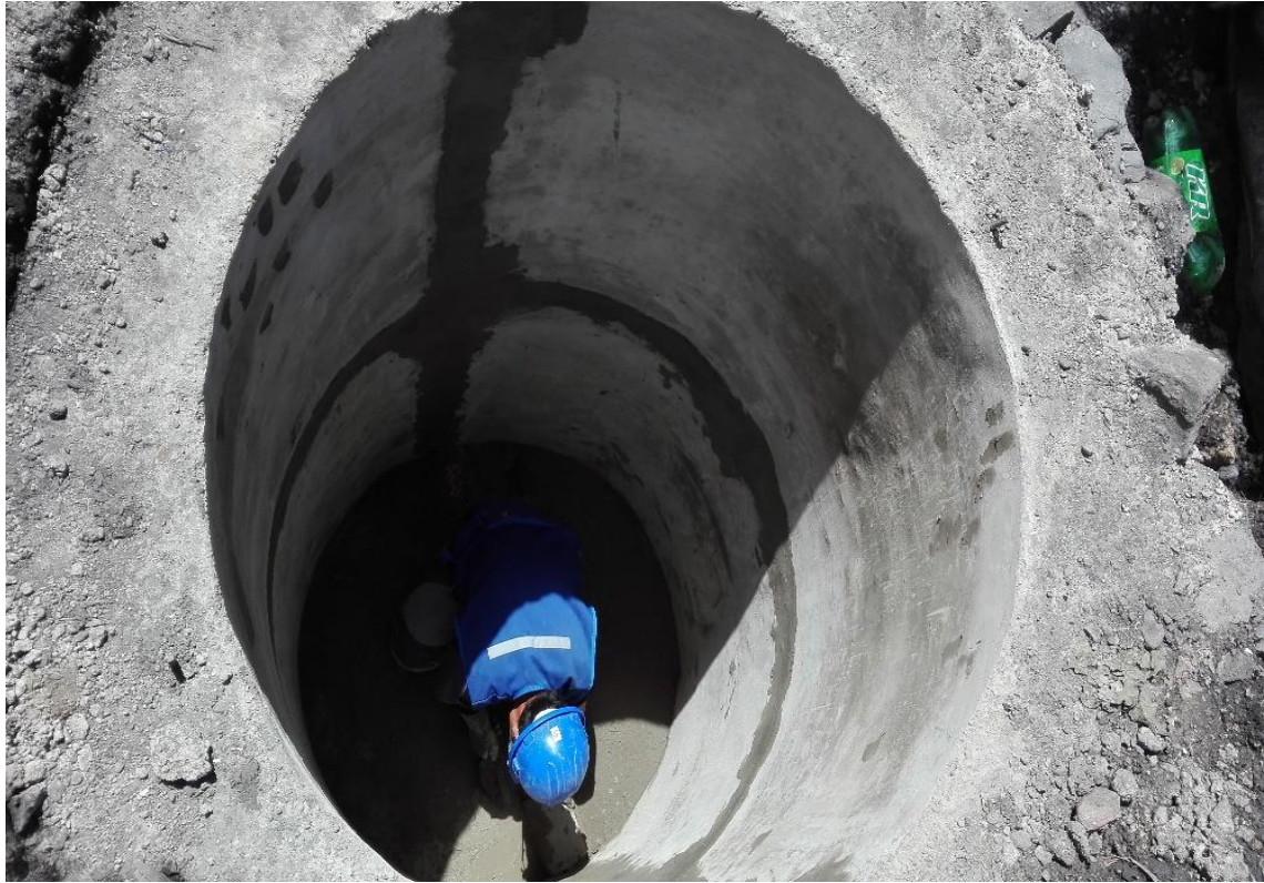
Foto N° 17 | Cámara de inspección de aproximadamente 2.00 metros de profundidad.
