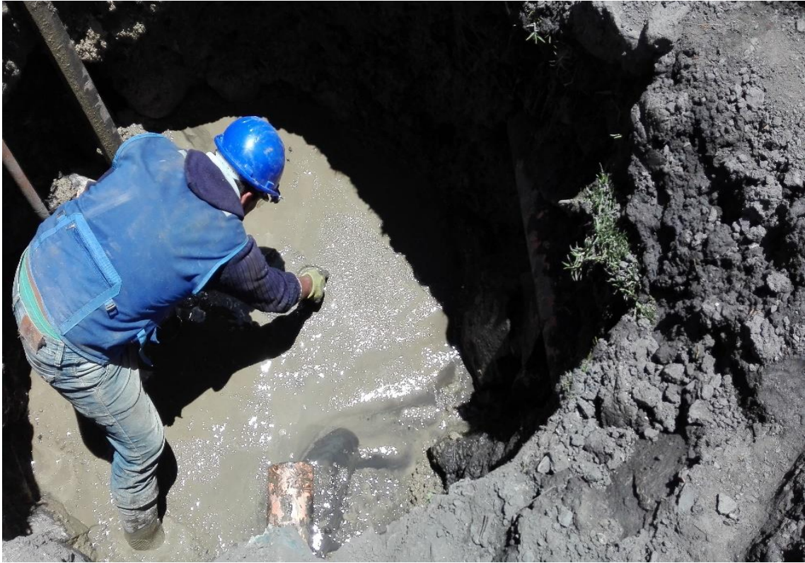
Foto N° 11 | Vaciado del solado para la cámara de inspección.
