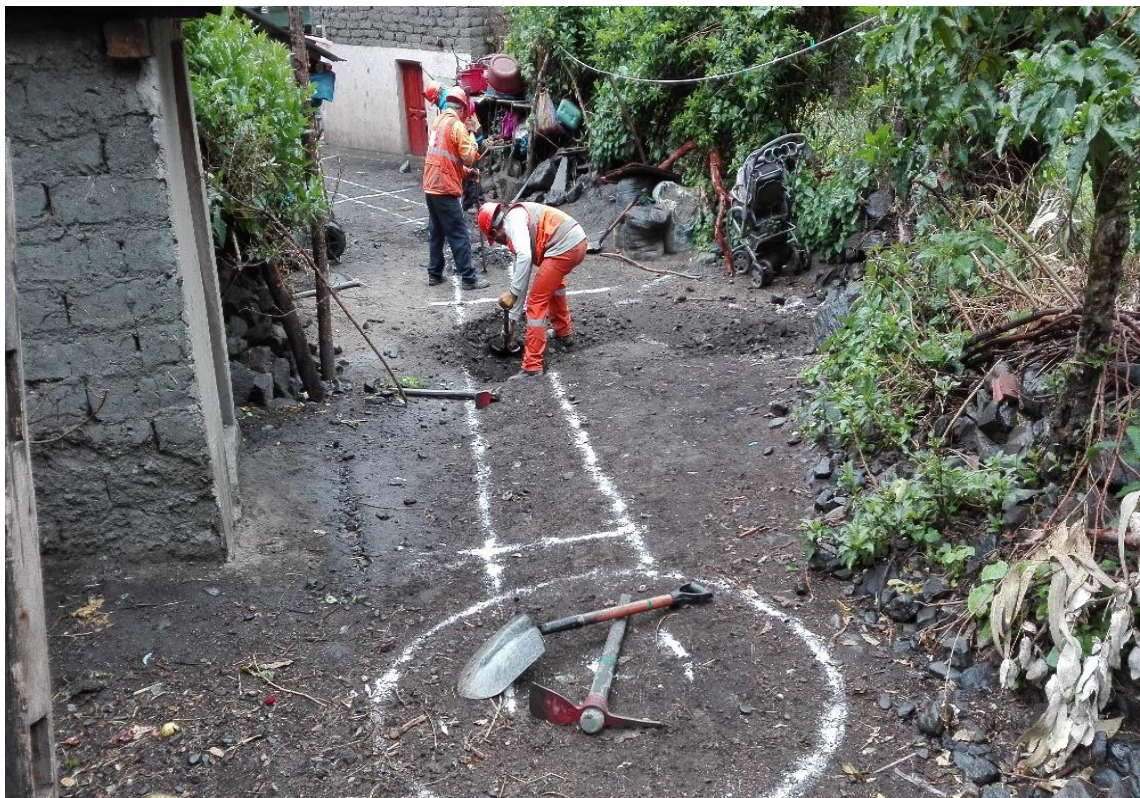
Foto N° 24 | Replanteo de la excavación para el sistema de desagüe.
