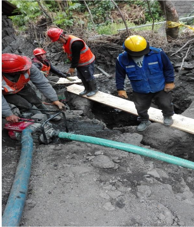
Foto N° 13 | Debido al terreno cohesivo se realizan trabajos con la motobomba.
