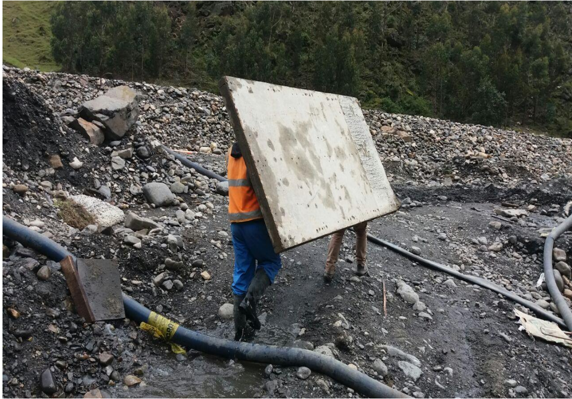
Foto N° 29 | Traslado de paneles para el encofrado de la planta de tratamiento.
