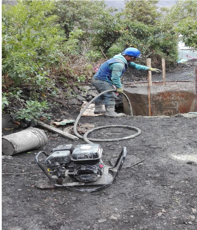
Foto N° 15 | Vibrado de la mezcla en el cuerpo de la cámara de inspección.
