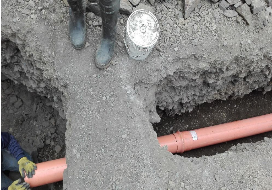
Foto N° 21 | Colocación de la tubería de PVC para el sistema de desagüe.
