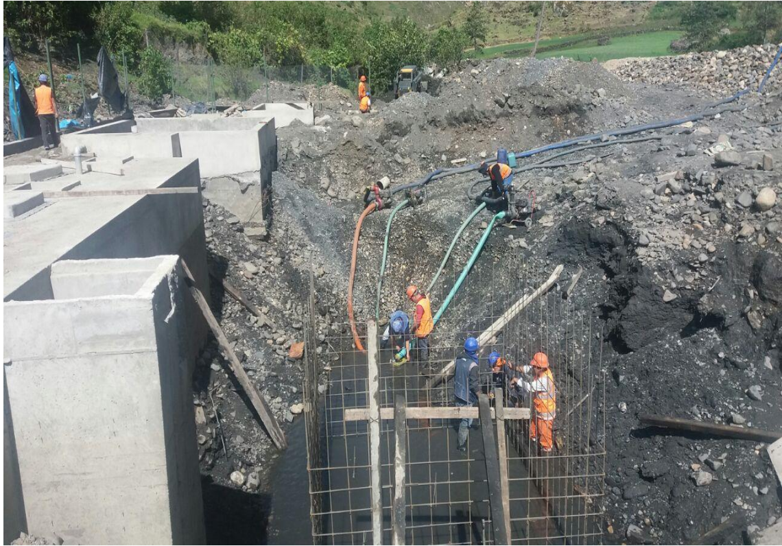
Foto N° 35 | Colocación de la armadura de acero para el lecho de secado.
