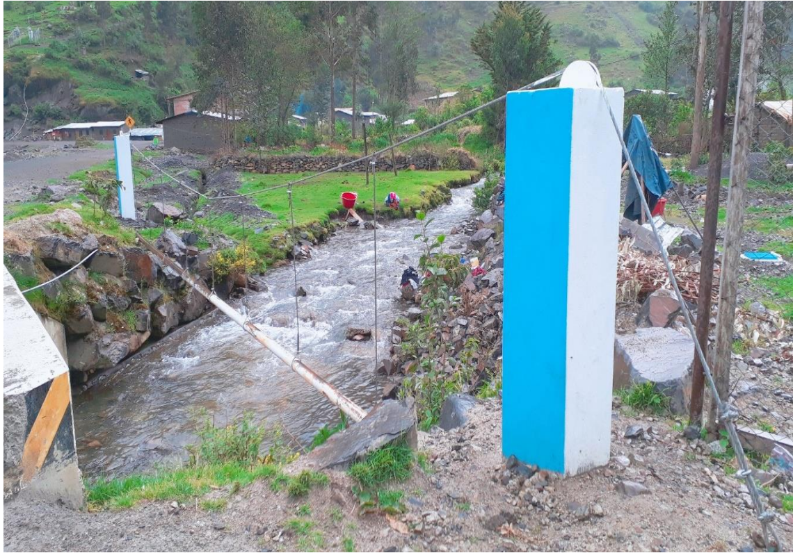
Foto N° 44 | Pase aéreo en la localidad de Quitaracsa.
