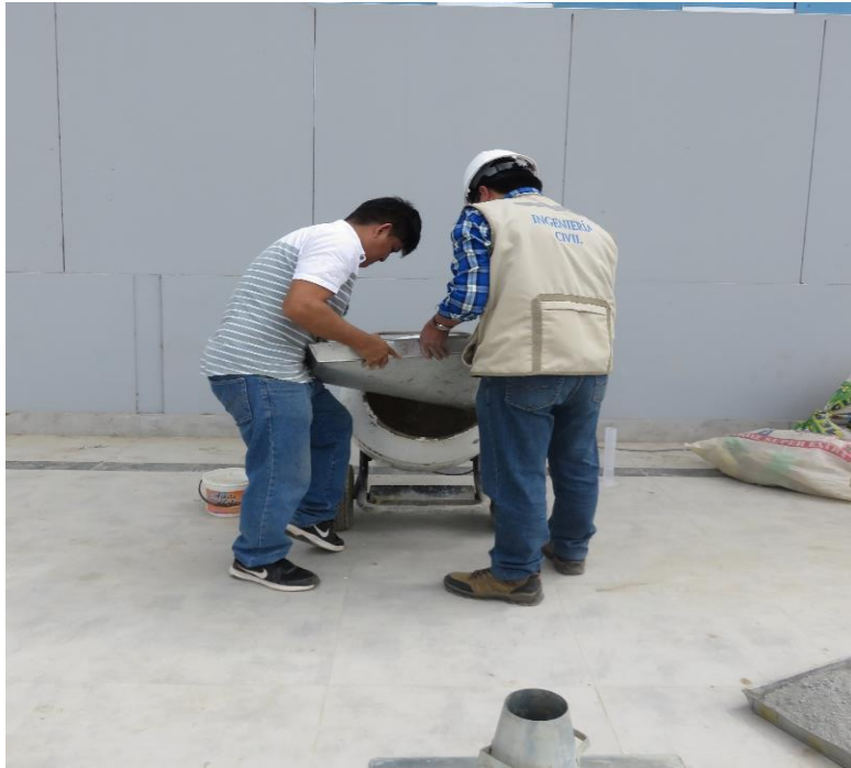
Vista de mezclado en mezcladora tipo trompo.
