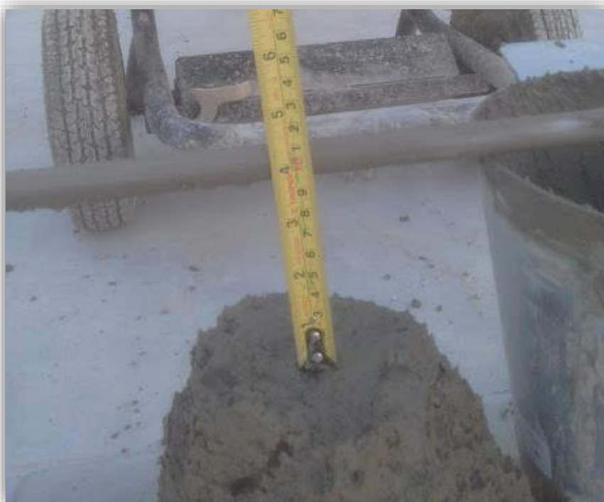
Se aprecia la medida de Slump del concreto patrón.
