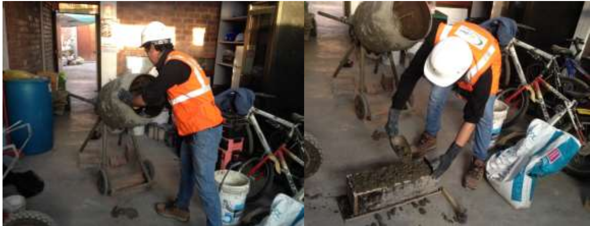
Figura 43. Encofrado de madera utilizados
