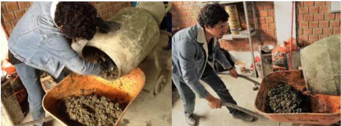
Figura 42. Trompo y mezcla preparada.
