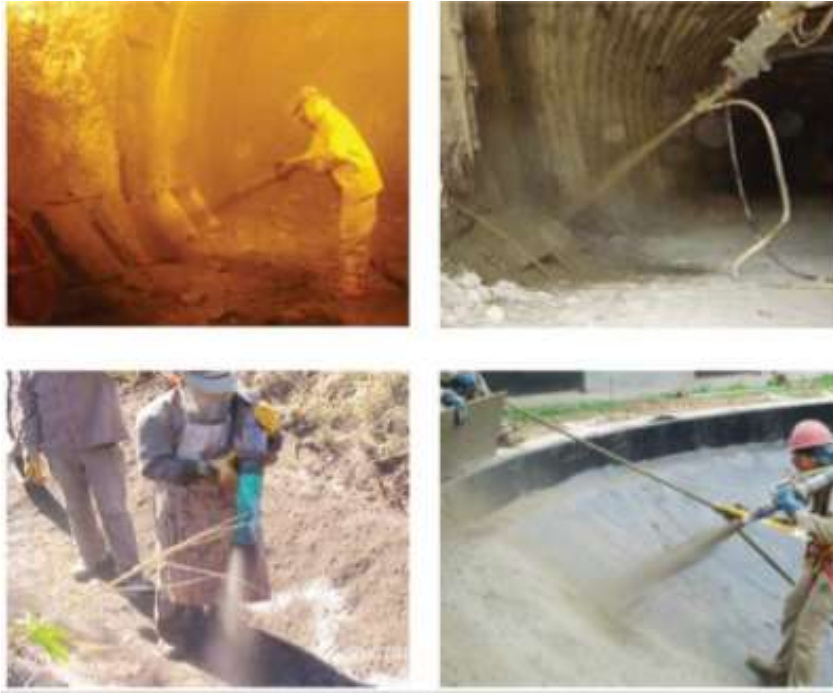
Figura 11. Concreto proyectado o Shotcrete
