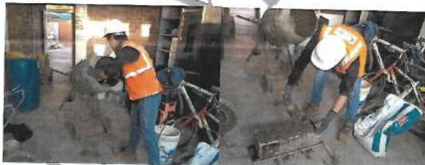
Figura 15. Encofrado de madera utilizados. Fuente: Elaboración propia.
