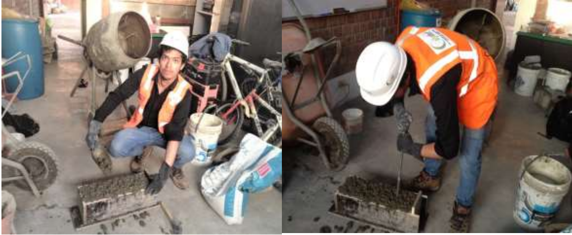
Figura 44. Consolidación del concreto mediante el método de apisonado.
