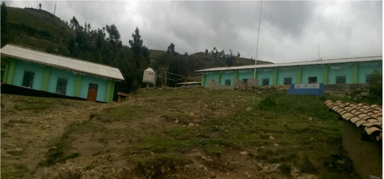
Figura 5: Almacén para agua de la I.E. 82138 - SURUAL
