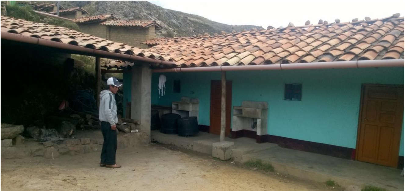
Figura 3: Área de cocina y comedor de la I.E. 82138 – SURUAL
