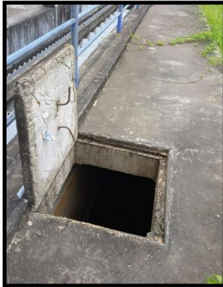
**Figura 24: Abertura del reactor anaeróbico**
