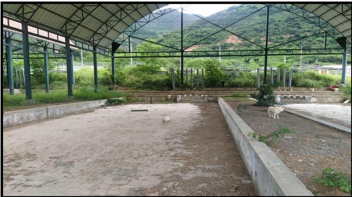
**Figura 27:Lecho de secado de lodos - PTAR Santa Ana**
