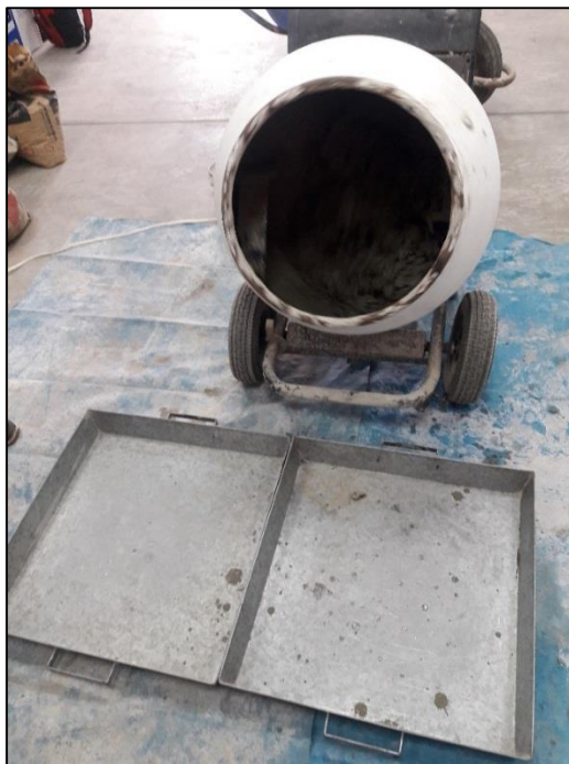
Anexo 2. Equipo de mezcla dispuesto para iniciar el trabajo.
