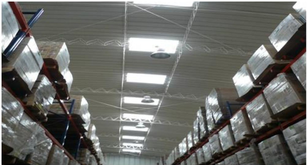
Figura 15. Interior del almacén
